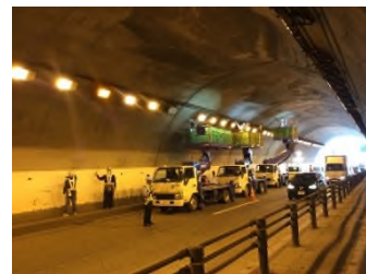
トンネルの点検状況
