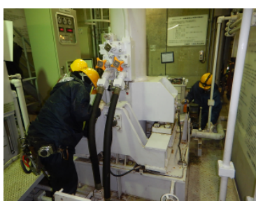
施設の点検（放流設備）
