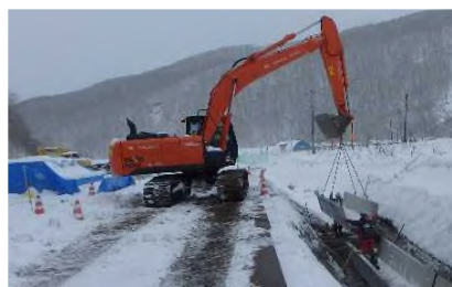
暫定的な用水路の敷設工事
