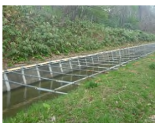
測壁傾倒への応急措置（切梁） （倶知安幹線用水路）
