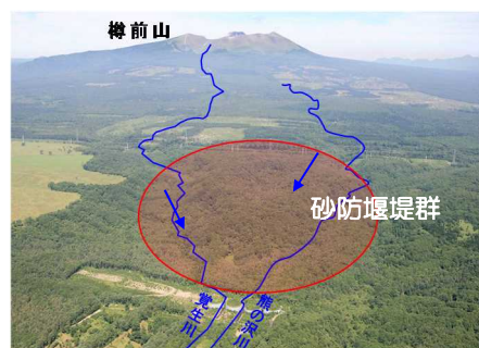
樽前山覚生川砂防堰堤群の整備
