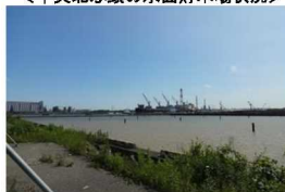
＜中央北ふ頭の水面貯木場状況＞
