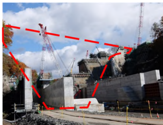
本体工事状況（平成30年10月撮影）
