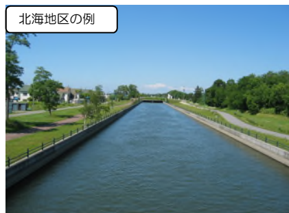
更新整備した用水路
