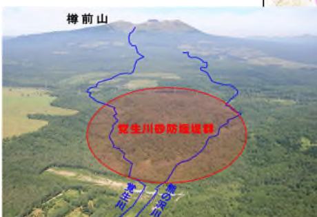
覚生川砂防堰堤群(建設中)
