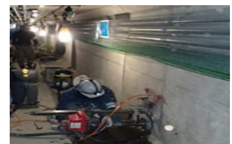
函館耐震対策施工状況
