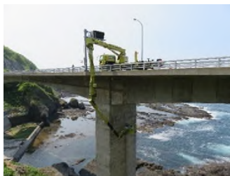
橋梁の点検状況
