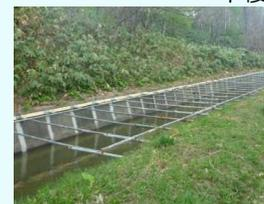
側壁傾倒への応急措置(劣化した幹線水路)
