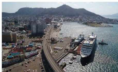
函館港大型クルーズ船係留 (2019年4月、水深8m暫定供用)
