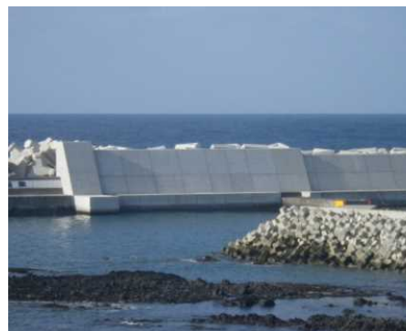
防波堤の嵩上げによる越波対策（江良漁港）
