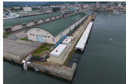
小樽港第3号ふ頭整備状況 (2018年7月時点)
