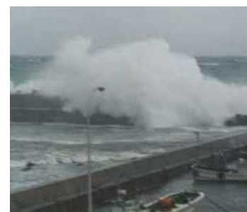
防波堤からの越波状況 (江良漁港)
