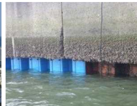
被覆防食による長寿命化対策（大津漁港）
