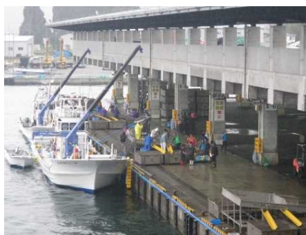
鳥糞等の異物混入を抑制する屋根付き岸壁の整備（ウトロ漁港）
