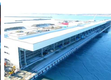
陸揚げ・荷捌作業における閉鎖した環境の整備（厚岸漁港）
