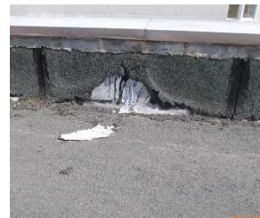
防水層の剥落
