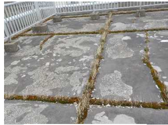
防水層の劣化
