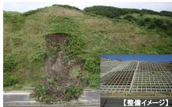
〈道路インフラの局所的な防災・減災対策等(法面对策)〉
