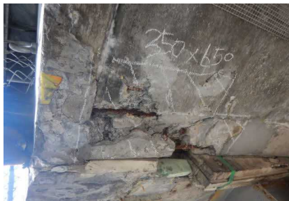
床板コンクリートの剥離・鉄筋露出状況
