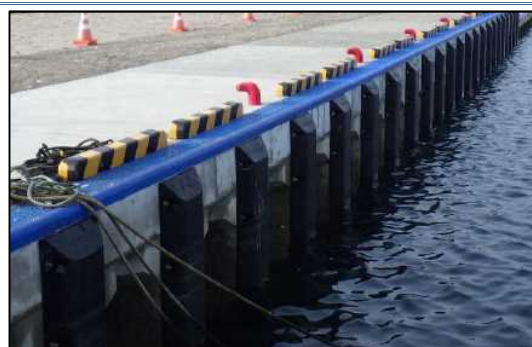
対策効果例(矢板が腐食した係留施設を改良し、安全な利用を確保)
