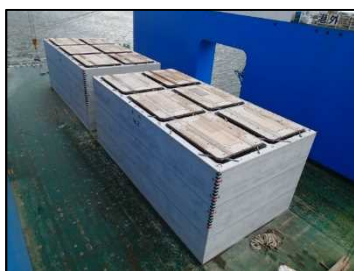
対策例(防波堤延伸のためのケーソン製作) 防波堤越流により岸壁へ波が遡上した例
