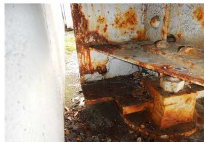
主桁・支承の腐食状況
