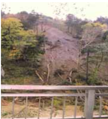
平成18年10月7日～9日発生 の低気圧による降雨により、石 狩川左岸の山腹法面が崩落。
