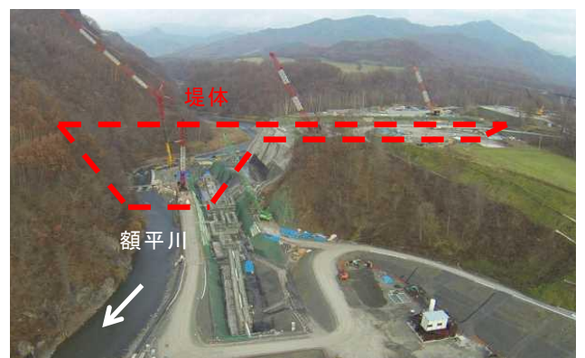
本体工事状況（平成27年11月撮影）
