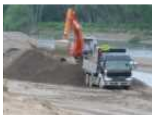
十勝川河道掘削
