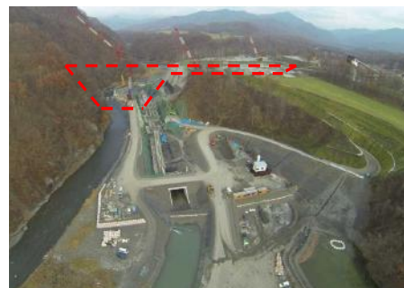
平取ダム（本体工事）
