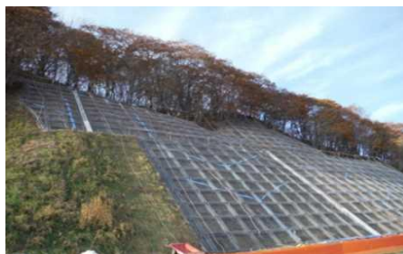
斜面崩落防止対策
