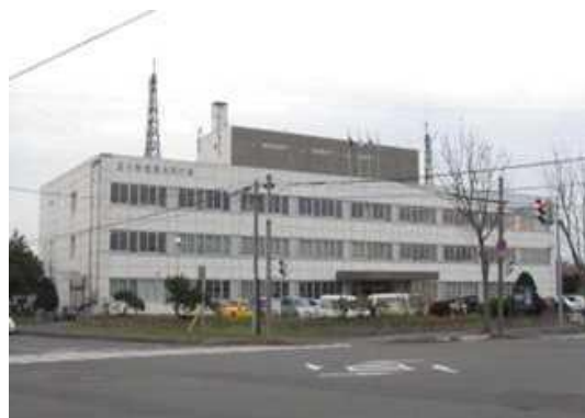
苫小牧港湾合同庁舎 長寿命化改修
