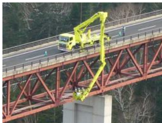
橋梁の点検状況
