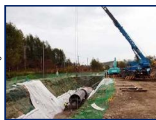
基幹的な農業水利施設の改修（管の交換状況）
