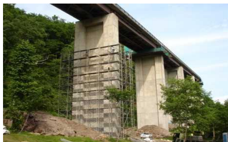
橋脚の耐震補強
