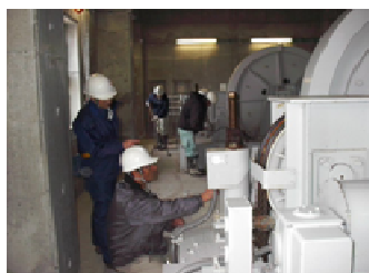
施設の点検（ダムゲート）
