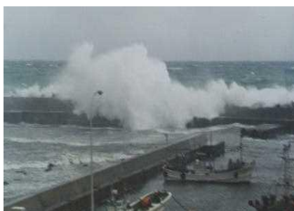
防波堤からの越波状況 (江良漁港)
