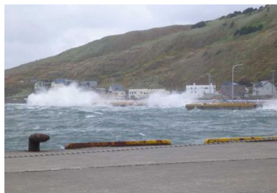
荒天時の越波等による港内擾乱(香深港)
