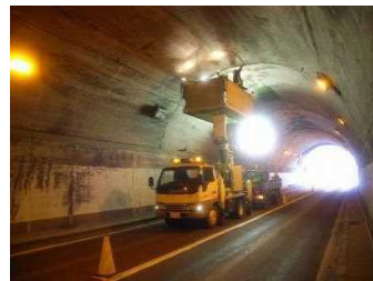
トンネルの点検状況
