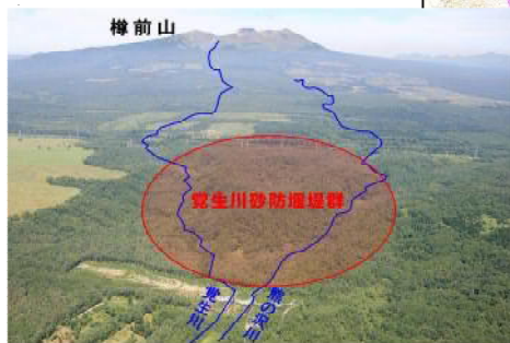
覚生川砂防堰堤群（建設中）
