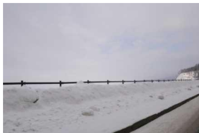
除雪前の状況
