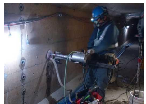
函館耐震対策施工状況
