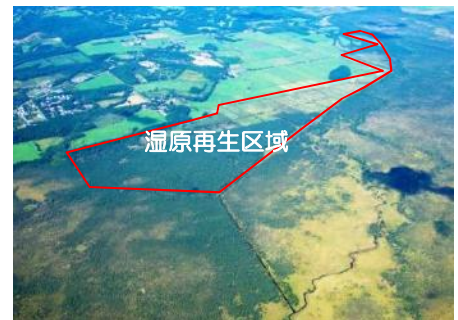
釧路湿原自然再生（幌呂地区湿原再生）
