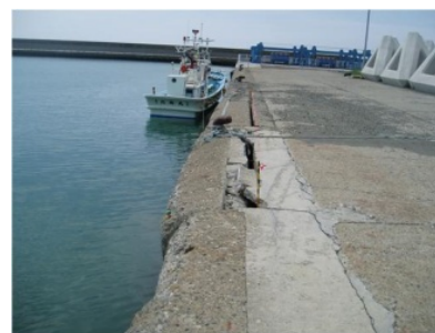
老朽化により危険な状況の岸壁 (庶野漁港)
