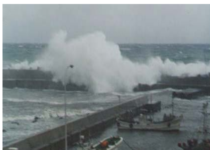
防波堤からの越波状況 (江良漁港)
