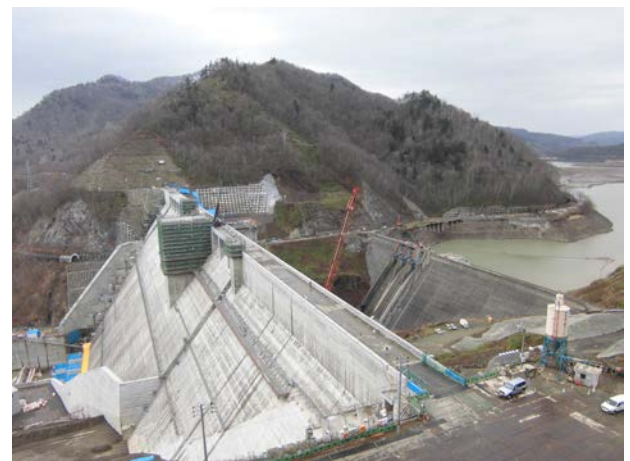
本体工事状況（平成25年11月撮影）
