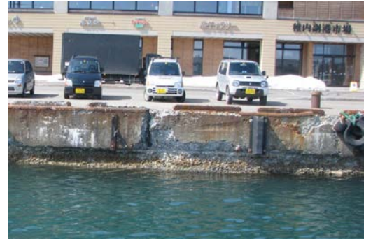
老朽化が著しい係留施設（稚内港）
