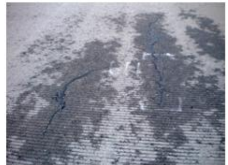
既設誘導路舗装の劣化状況
