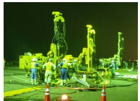
液状化対策施工状況
