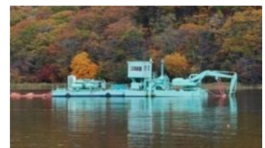
底泥浚渫状況
