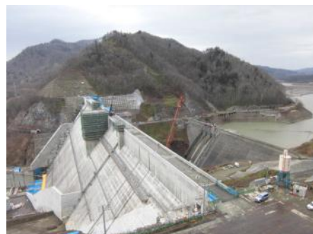
タ張スーパーパロダム（本体工事）
