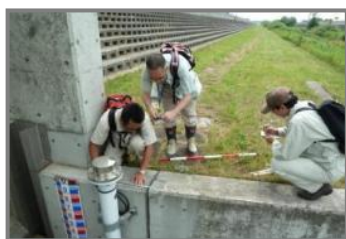
施設の点検（樋門）
