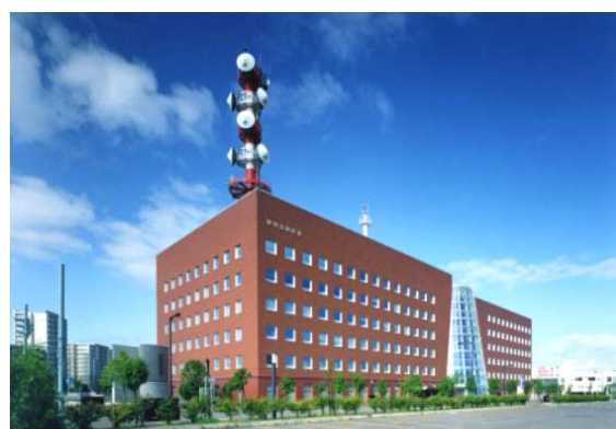
旭川地方合同庁舎 地震時落下防止特定天井改修
