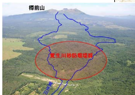
覺生川砂防堰堤群(建設中)
