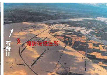
石狩川右岸 下新篠津付近の氾濫状況 （江別市）
