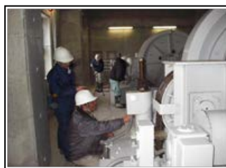
施設の点検（ダムゲート）
