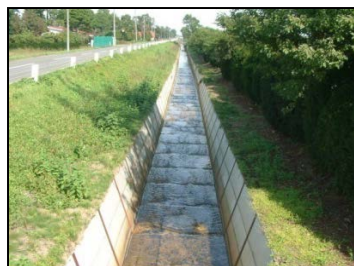
排水路の整備
