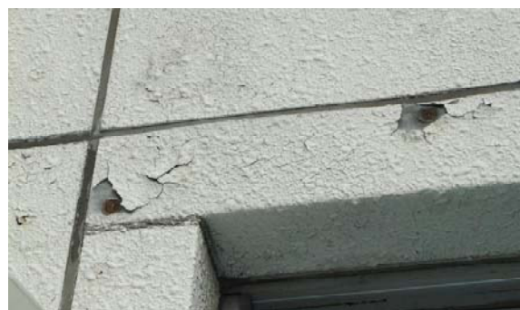
帯広地方合同庁舎 外壁・建具改修
