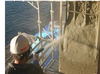
断面修復による長寿命化
