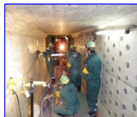
耐震補強対策施工状況 【新千歳空港】
