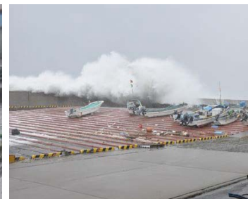
防波堤からの越波状況
