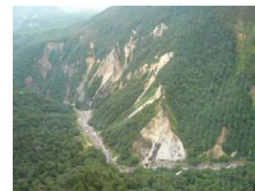
山地の荒廃状況(層雲峡地区)
