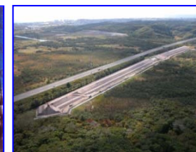
樽前山 苫小牧川 遊砂池の整備
