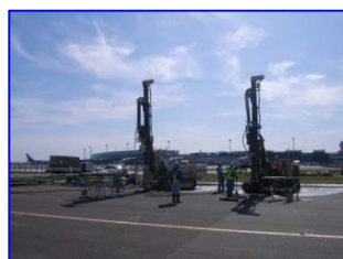
新千歳空港の液状化対策施工状況
