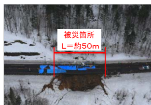
▲ 土砂崩れによる道路寸断状況 （一般国道230 中山峠 H25.4）
