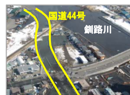
▲ 東日本大震災(H23.3.11)の津波による道路冠水状況(国道44号 釧路市)
