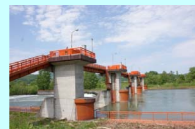
頭首工堰柱の耐震補強
