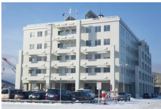
耐震改修の事例（函館港湾合同庁舎）
