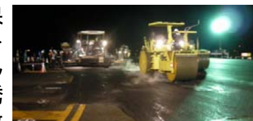
誘導路の舗装改良
