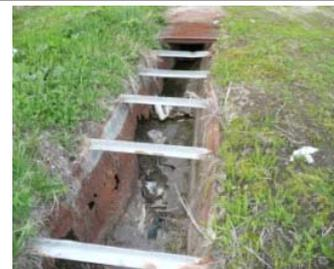
老朽化した鉄板水路
