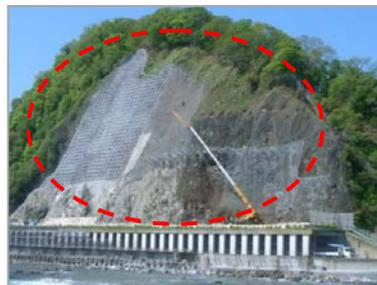
斜面崩落防止対策（現場吹付法砕工）
