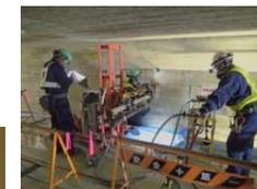
耐震補強(削孔状況)
