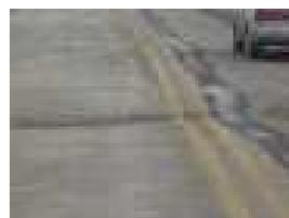
大規模地震時の液状化による誘導路変状（東日本大震災時の仙台空港）
