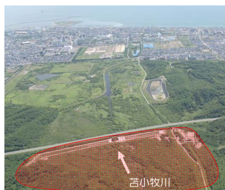
苫小牧川遊砂地(建設中)
