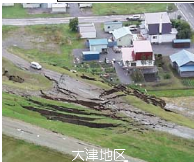
平成15年十勝沖地震による堤防被災状況
