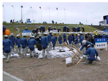
水防公開演習の実施（釜段工）
