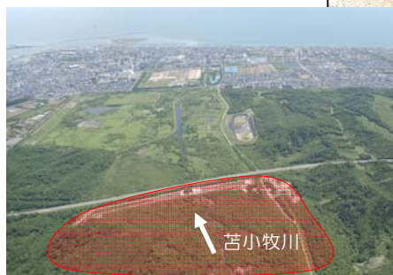
苫小牧川遊砂地(建設中)
