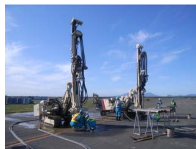
液状化対策施工状況
