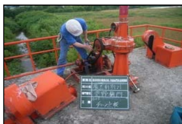
機能の維持と適切な修繕のため 点検を実施
