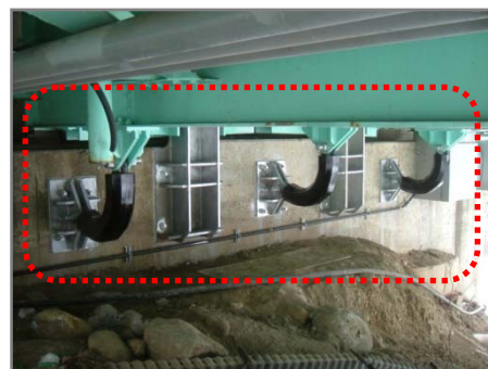
【落橋防止装置の設置例】
