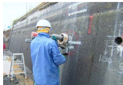
農業水利施設の機能診断状況 【国営かんがい排水事業】
