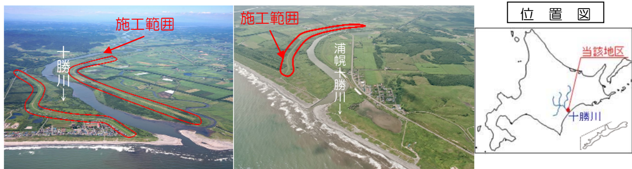
堤防法尻ドレーン工施工状況
