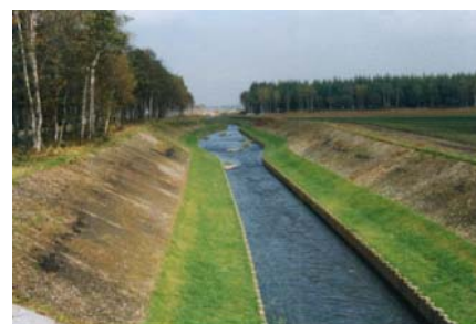
排水断面が拡幅された排水路 【国営かんがい排水事業】
