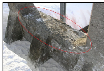
巡視や点検にて劣化や損傷が 確認された施設の修繕を実施
