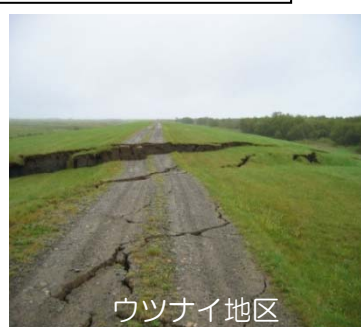
平成15年十勝沖地震による堤防被災状況
