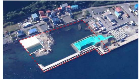
整備中の耐震強化岸壁（香深港〔礼文島〕）
