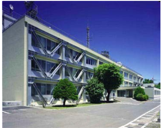
耐震改修の事例
