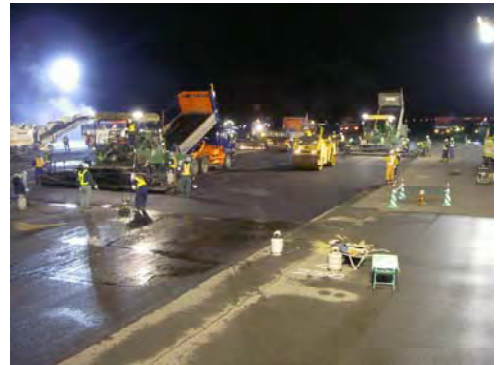
アスファルト舗装舗設状況
