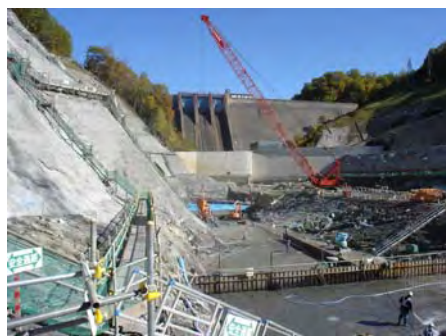
夕張スーパーパロダム建設状況
