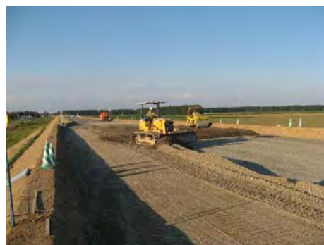
帯広広尾自動車道 川西中札内道路
