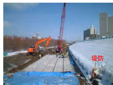
豊平川堤防の高速流対策
