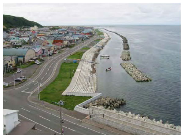
稚内港海岸（ノシャップ地区）整備状況
