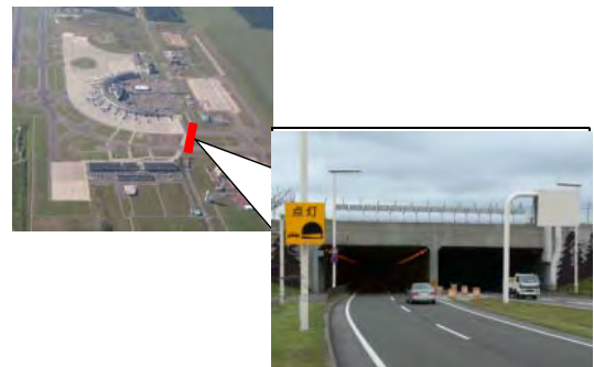
新千歳空港耐震対策（地下道トンネル強化）
