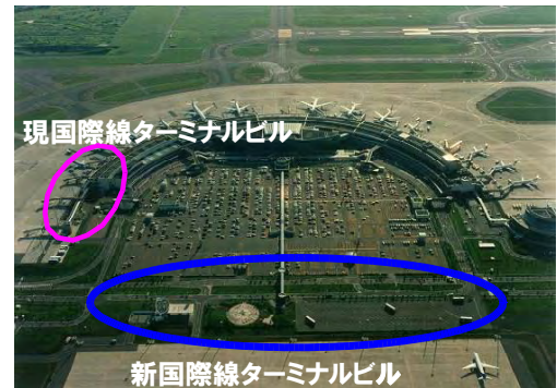
新千歳空港 新国際線ターミナル整備
