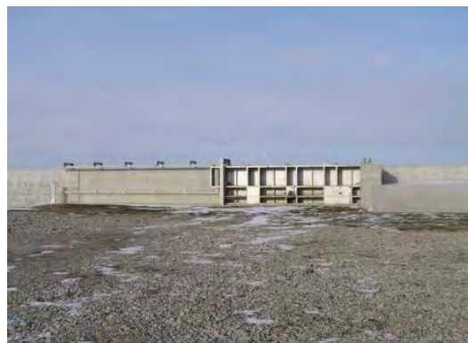
霧多布港海岸（霧多布地区）陸間
