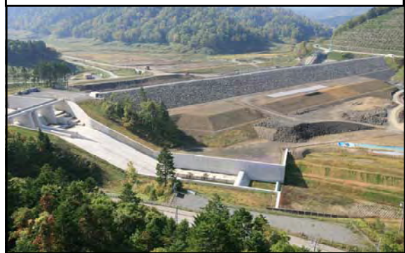
右岸からダム全景（H19年10月撮影）
