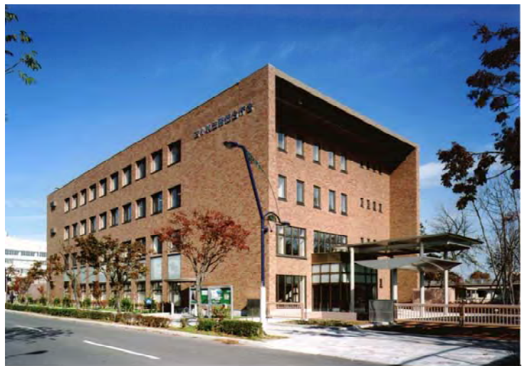
苫小牧法務総合庁舎 外観写真
