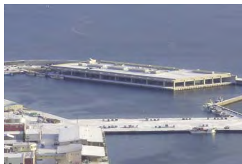
高度な衛生管理に対応した 羅臼漁港の全天候型埠頭（人工地盤）
