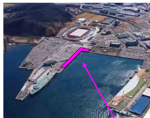
室蘭港 耐震強化岸壁整備箇所
