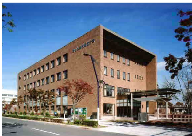
苫小牧法務総合庁舎 外観写真
