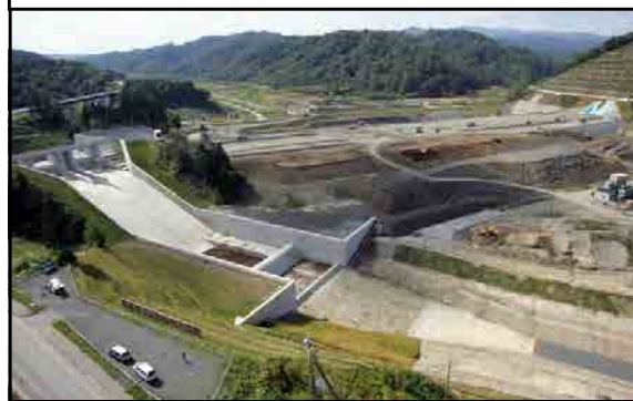
右岸からダム全景（H18年9月撮影）
