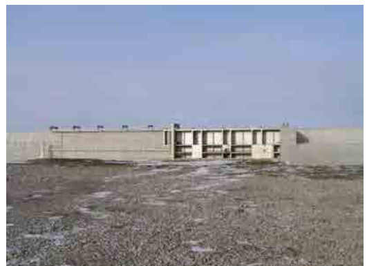
霧多布港海岸（霧多布地区）陸間
