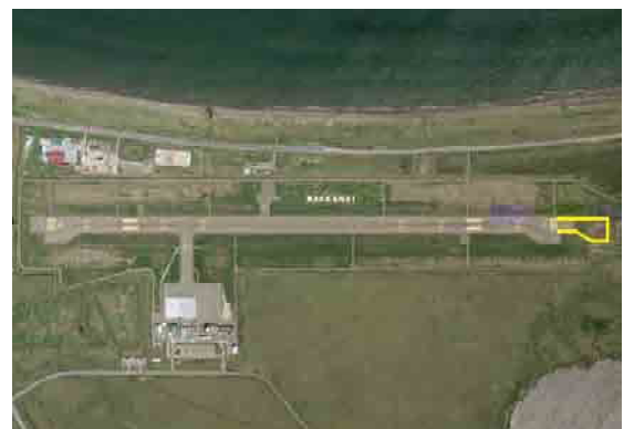
稚内空港滑走路改良箇所
