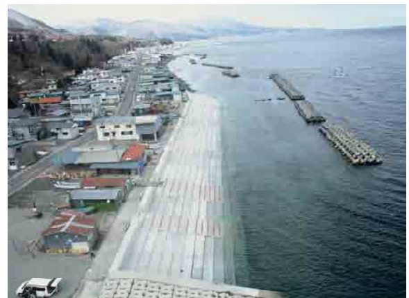
尾 札 別 海 岸（函 館 市）緩 傾 斜 護 岸
