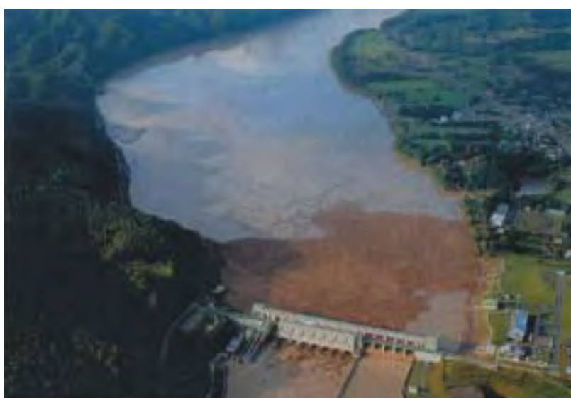
二風谷ダムに捕捉された大量の流木（平成15年8月10日）
