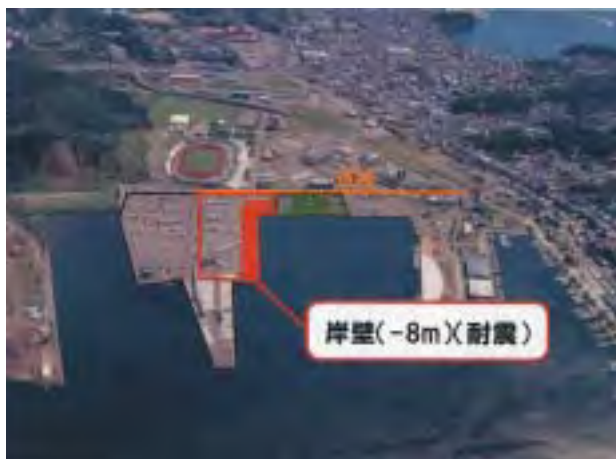
室蘭港入江地区耐震強化岸壁整備 (既存岸壁の耐震強化)
