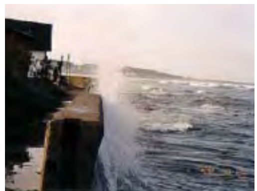
枝幸港海岸（本港地区）
