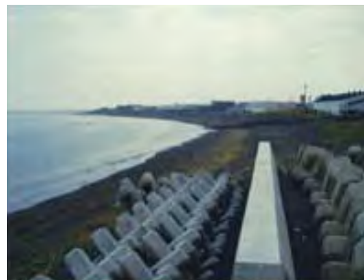
紋別港海岸 護岸整備状況
