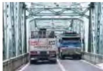
大型車のすれ違いが困難な状況
