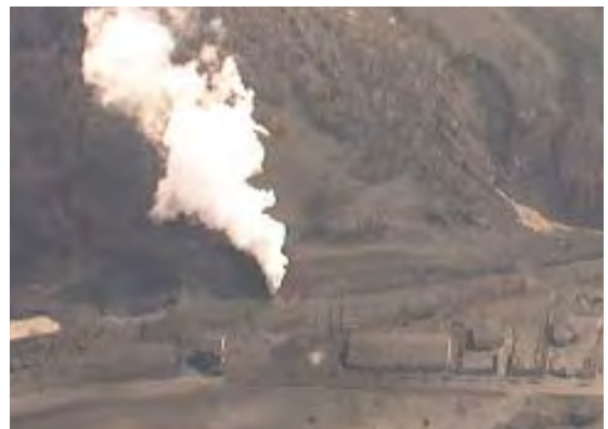
有珠山火山活動により国道230号上に発生した火口 (H12. 4. 2撮影)
