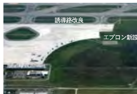
新千歳空港エプロン新設・誘導路改良
