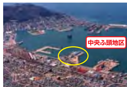
函館港中央ふ頭地区 既設岸壁の改良
