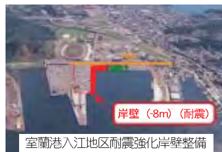
既存岸壁の耐震強化
