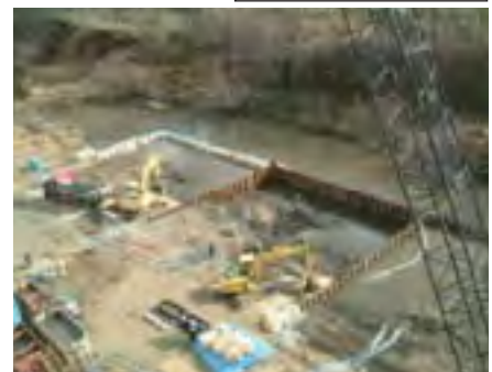
試験掘削状況
