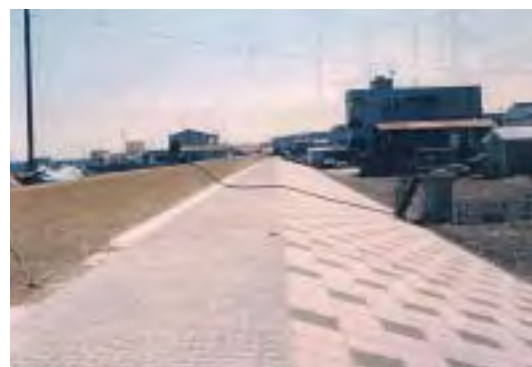
霧多布港海岸 堤防整備状況
