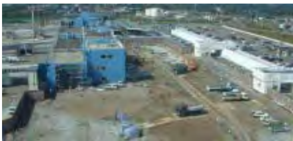
ターミナル工事風景
