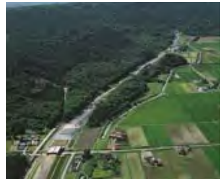
旭川・紋別自動車道 愛別上川道路
