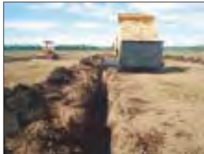
暗渠排水 疎水材(カラマツチップ材)投入状況
