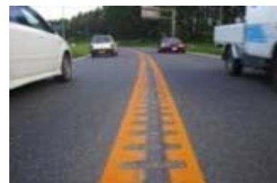
図5 ランブルストリップス設置状況
