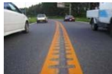
図5 ランブルストリップス設置状況
