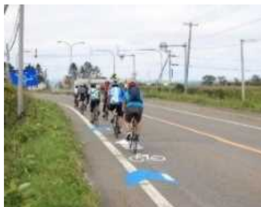
路面への通行位置明示
