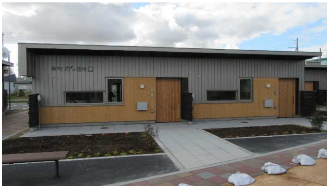
写真 2-5-8 厚真町災害公営住宅
