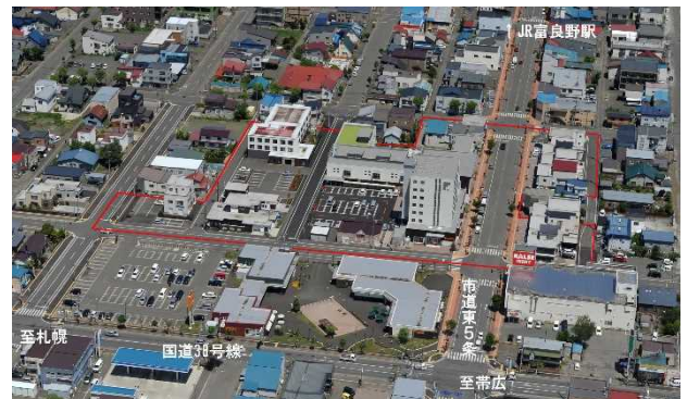
写真 2-5-6 東4条街区地区市街地再開発事業（富良野）
