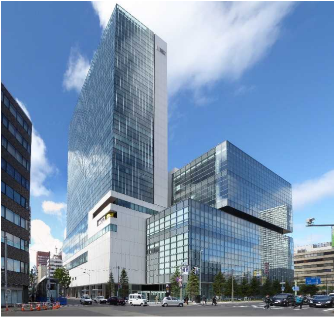
写真 2-5-7 札幌創世 1.1.1 区北 1 西 1 地区市街地再開発事業
