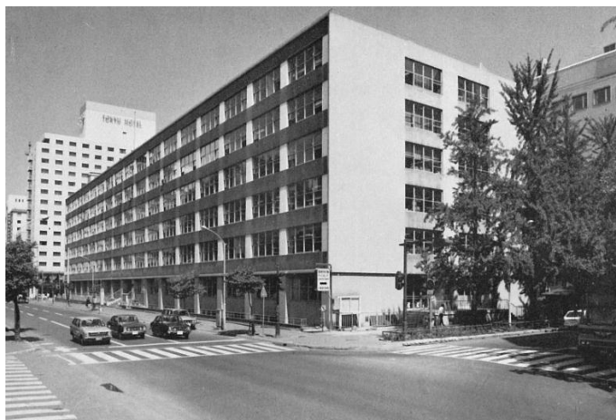
図10-4 旧札幌第1地方合同庁舎（昭和36年完成）
