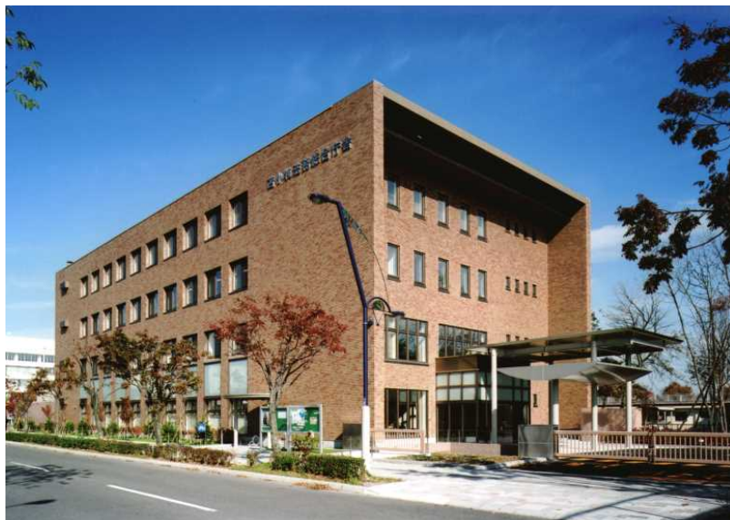
図 10-1 PFI 方式により調達した苫小牧法務総合庁舎
