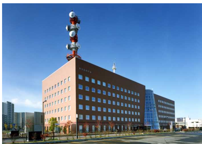
図10-5 旭川地方合同庁舎（平成20年完成）
