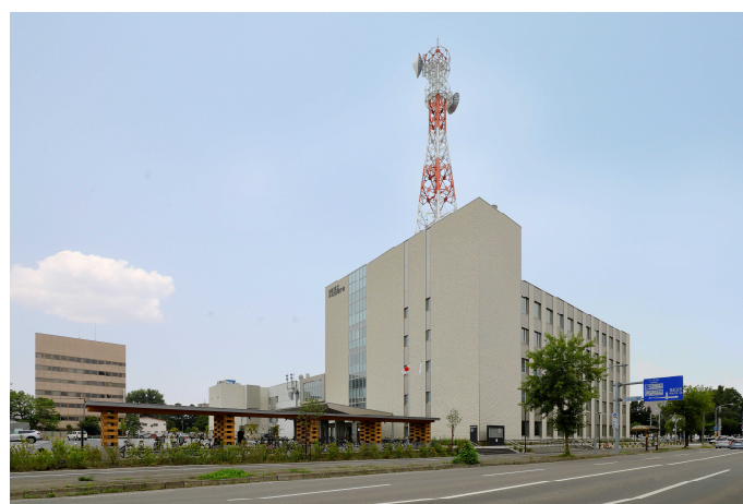
図10-6 帯広第2地方合同庁舎（令和元年完成）
