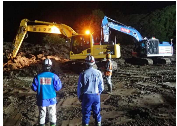
図ー 6 平成 30 年北海道胆振東部地震にて分解組立型バックホウにより道路啓開を行う開発局の TEC-FORCE 隊員
