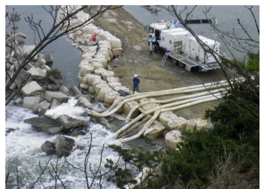
図－8 東日本大震災にて排水ポンプ車にて排水活動を実施
