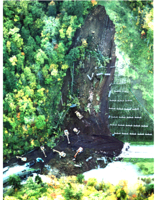
図－41 崩落箇所全景
