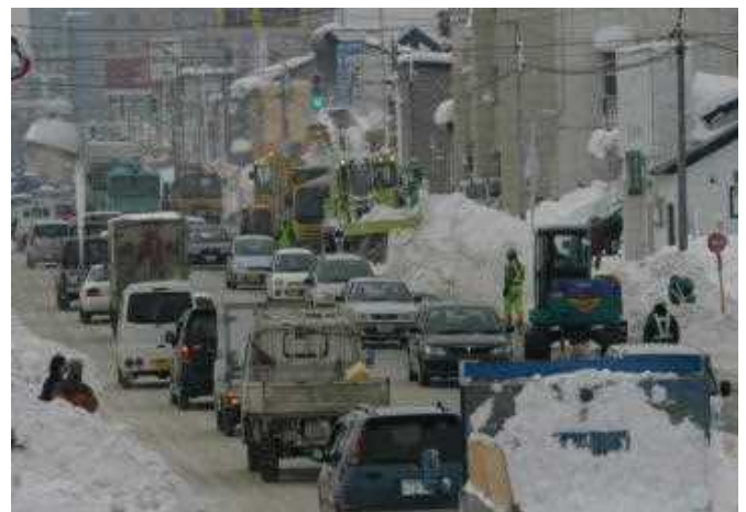
図－38 大雪で渋滞する国道39号北見市内で行われている運搬排雪作業
