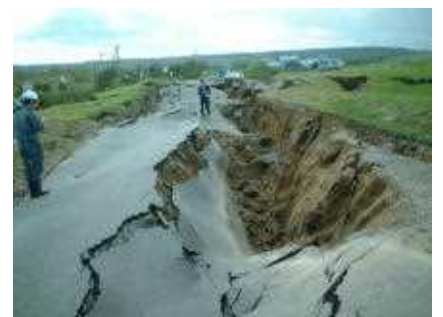
図－13 十勝川大津付近の築堤被災状況
