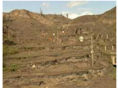
図-33 国道 230 号上に出現した断層
