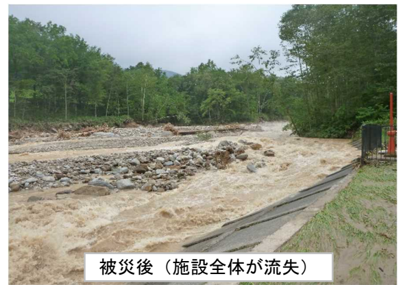
図－30 頭首工の被災（清水町）
