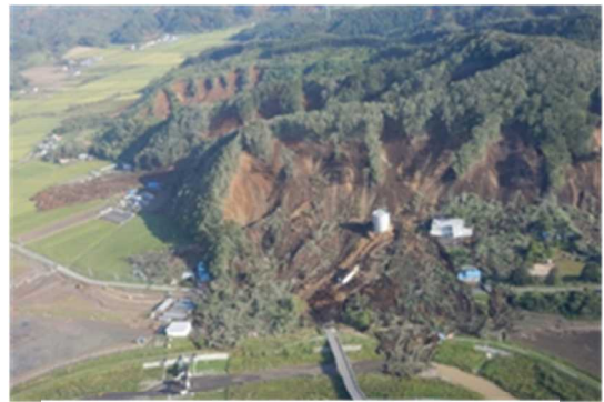
図－17 富里浄水場被災状況
