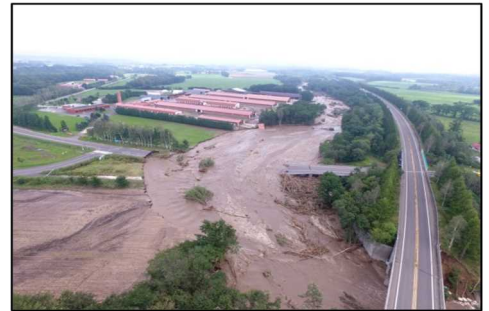
図-26 国道 38 号小林橋の被災状況
