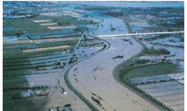
図－20 江別市早苗別付近の千歳川合流点の氾濫状況
