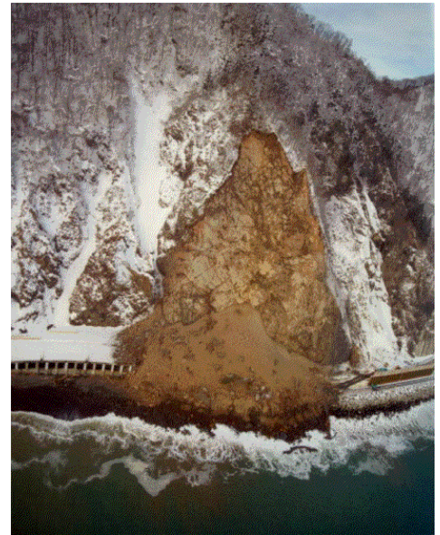
図－42 崩落箇所全景
