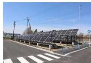
道の駅「あびら 051 ステーション」太陽光発電設備(安平町)
