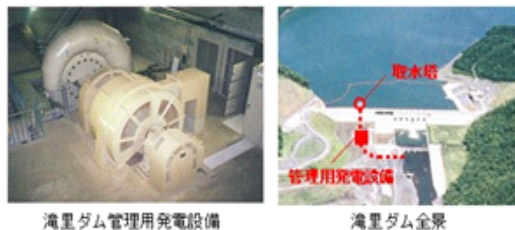
滝里ダム管理用発電設備
