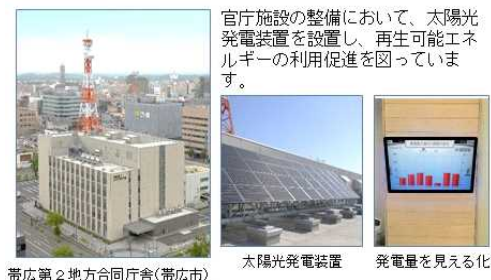
帯広第 2 地方合同庁舎(帯広市)
