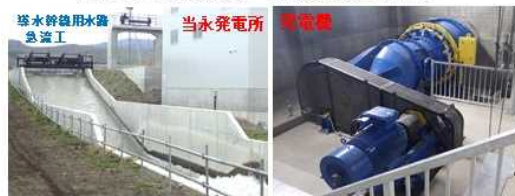
当永発電所全景
