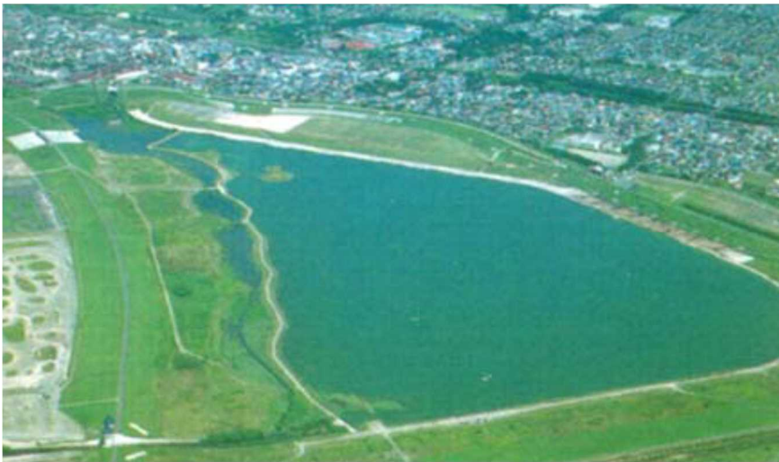
図 3-1-2-56 砂川オアシスパーク（石狩川水系砂川遊水地）
