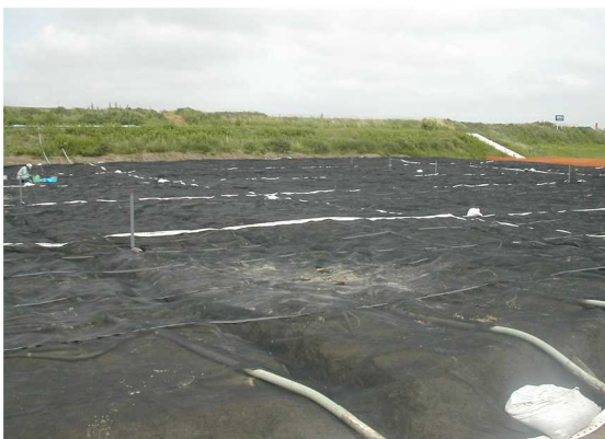
図 3-1-2-40 真空圧密工法の施工状況（築堤前）
