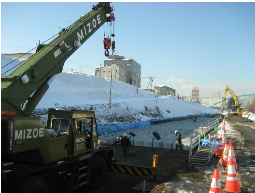
図 3-1-2-52 石狩川支川豊平川堤脚保護工施工状況
