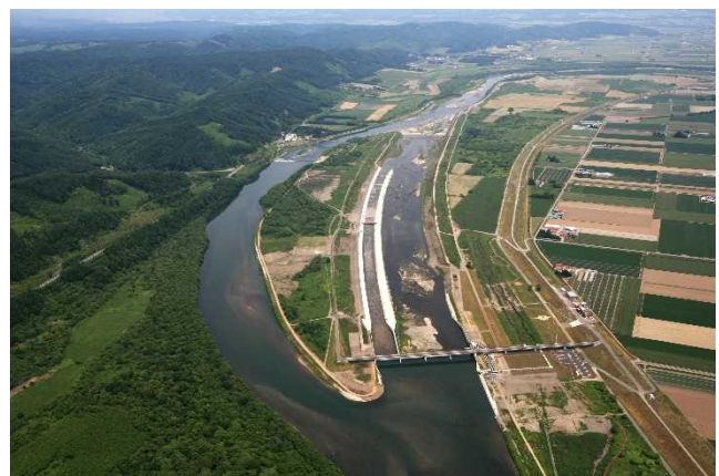
図 3-1-2-13 千代田新水路（平成 18 年度完成）
