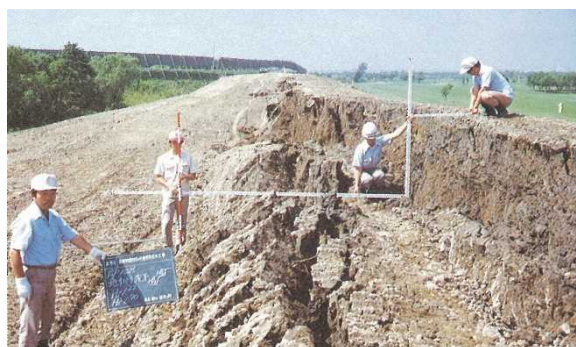
図 3-1-2-22 軟弱地盤上の堤防盛土が破壊した事例
