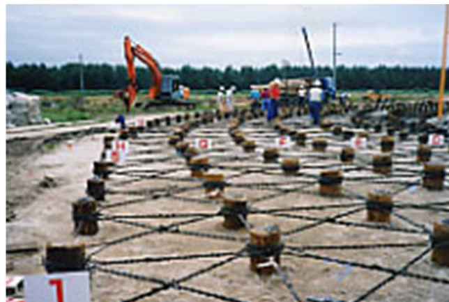
図 3-1-2-35 同左による鉄筋連結状況
