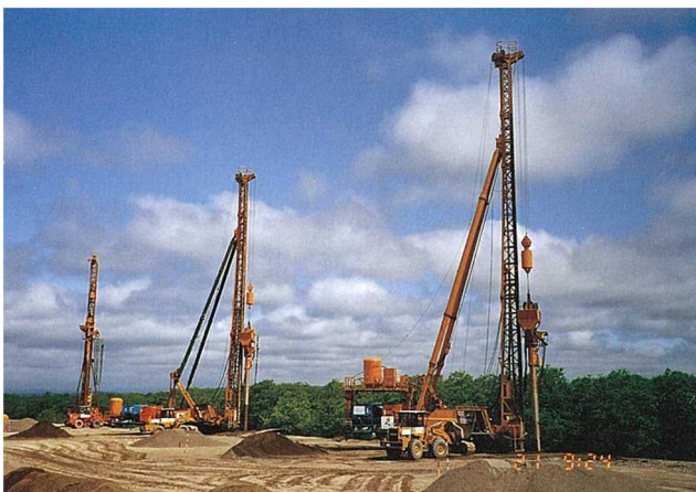
図 3-1-2-32 サンドコンパクションパイルによる改良
