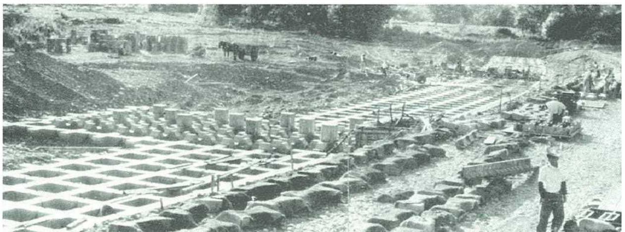
図 3-1-2-50 十勝川支川札内川低水路コンクリート根固工護岸 (昭和 34 年)
