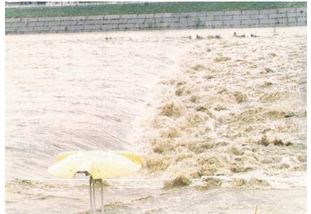
図 3-1-2-16 洪水時の床止付近の流況(昭和 56 年)
