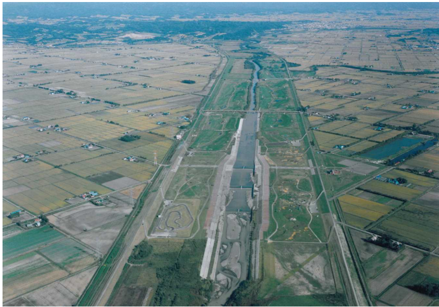
図 3-1-2-17 清幌床止（夕張川）（平成 4 年度完成）
