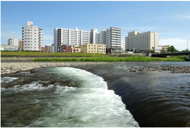
图 3-1-2-20 豊平川 3号床止工（平成 23 年度改築）
