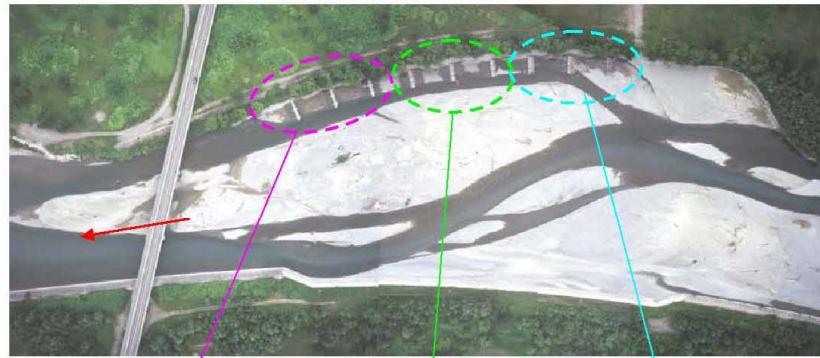
施工1年後の航空写真 (H16.7撮影)
