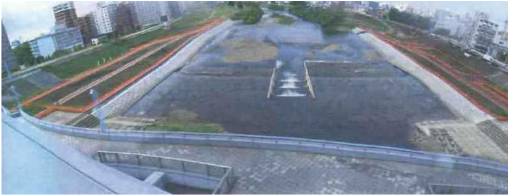
图 3-1-2-19 豊平川 6・7号床止工（平成 21 年度完成）
