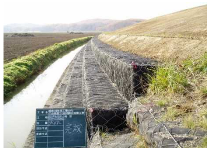
図 3-1-2-30 網走川裏法尻ドレーン工法
