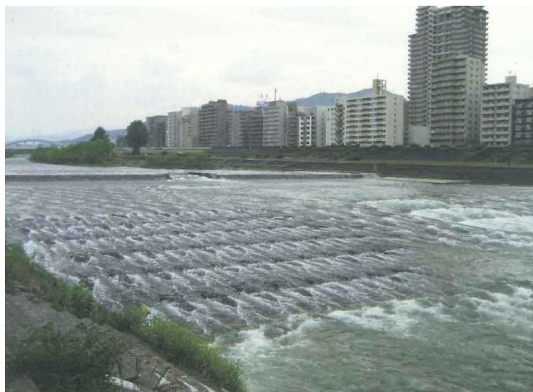
図 3-1-2-18 豊平川 5 号床止工（平成 19 年度完成）
