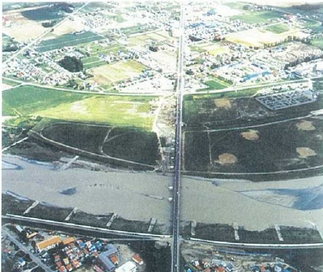
図 3-1-2-53 十勝川支川札内川札内橋附近の水制工
