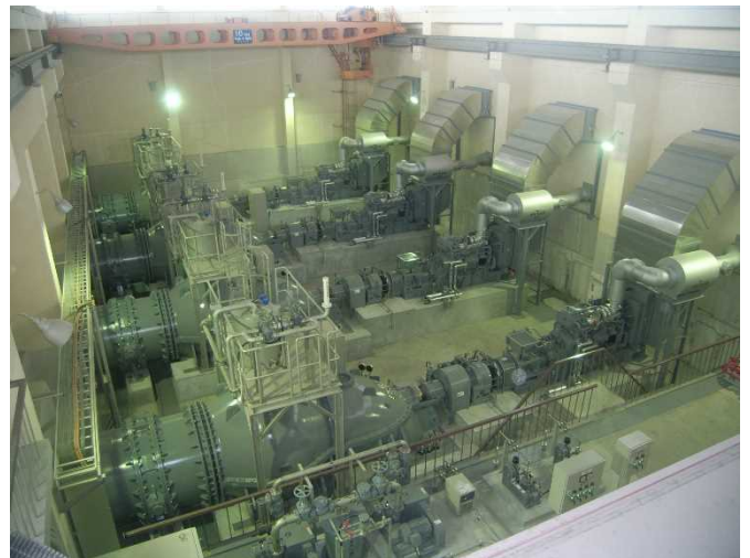
図 3-1-2-43 同左ポンプ場
