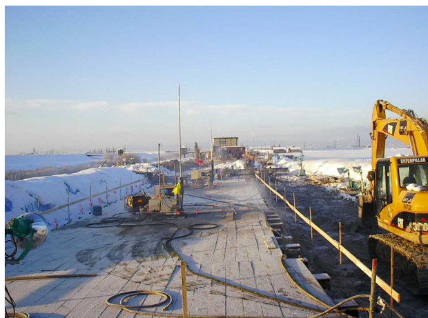
図 3-1-2-36, 37 清真布川の復旧工法（高圧噴射攪拌工法）
