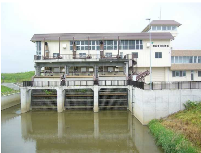
図 3-1-2-44 南 6 号排水機場（遠隔操作可能）
