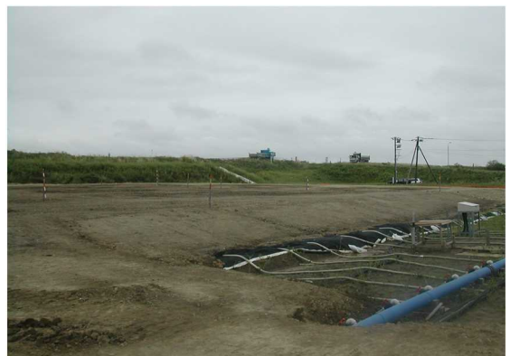
図 3-1-2-41 真空圧密工法の施工状況（築堤時）
