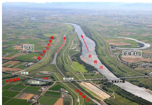
図 3-1-2-9 幾春別川新水路（平成18年度完成）
