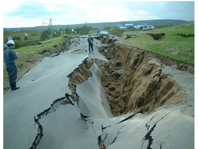
図 3-1-2-27 平成 15 年十勝沖地震 十勝川
