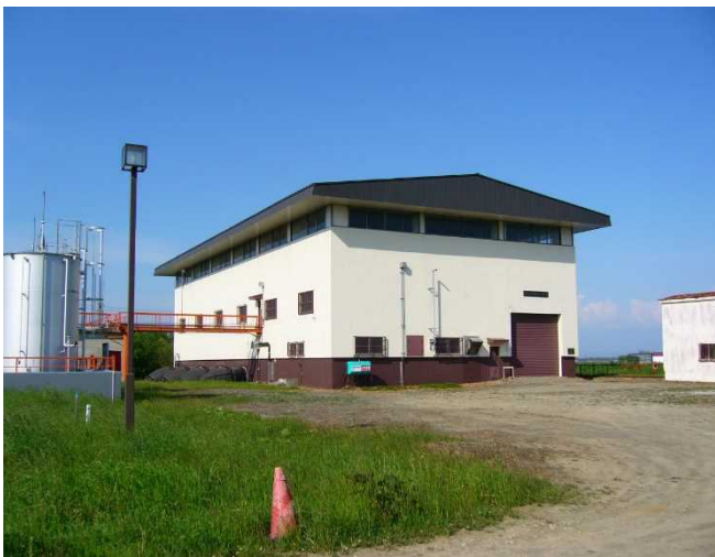
図 3-1-2-42 篠津川排水機場
