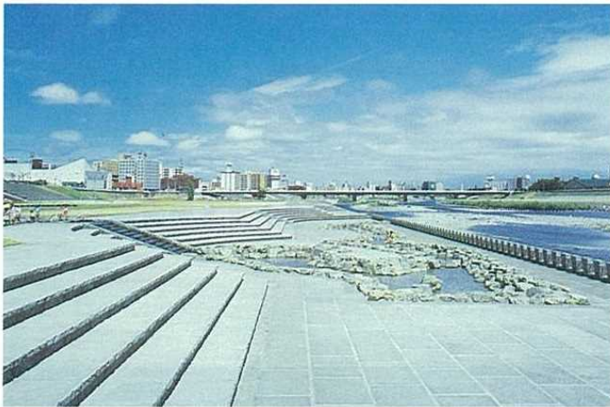
図 3-1-2-54 石狩川支川豊平川低水護岸
