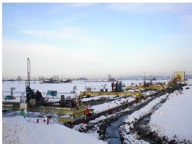
図 3-1-2-36, 37 清真布川の復旧工法（高圧噴射攪拌工法）
