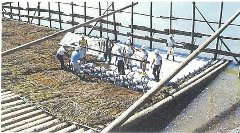
図 3-1-2-51 台棒足場施工状況
