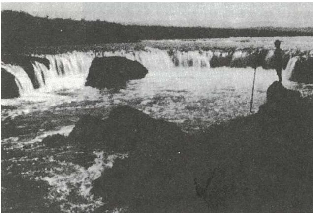
図 3-1-2-15 夕張川新水路通水後まもなくの状況 (昭和 12 年 6 月) 河床洗掘が 1 日 5.7m も進む
