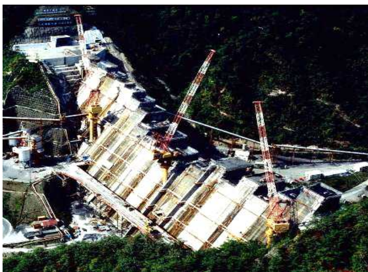
図 3-1-3-8 ジブクライミングクレーン 3 基でコンクリート打設中の定山溪ダム（昭和 61 年夏）
