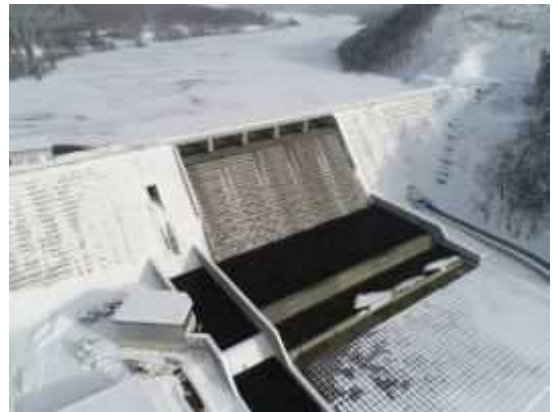
図 3-1-3-46 試験湛水中のサンプルダム
