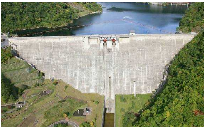
図 3-1-3-7 定山溪ダム（平成 2 年 3 月竣工）
