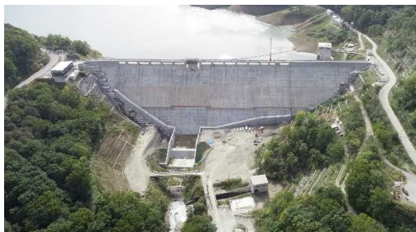
図 3-1-3-54 建設中の新桂沢ダム（令和 2 年 9 月）
