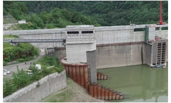
図 3-1-3-56 取水放流設備
