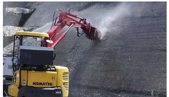
図 3-1-3-57 既設堤体下流面チップング状況
