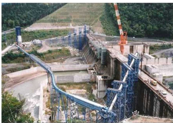
図 3-1-3-16 コンクリート打設状況 (パイプベルトコンベア)
