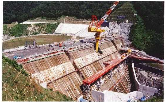
図 3-1-3-12 堤体打設状況
