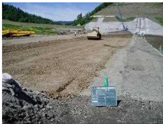
図 3-1-3-35 盛立施工状況
