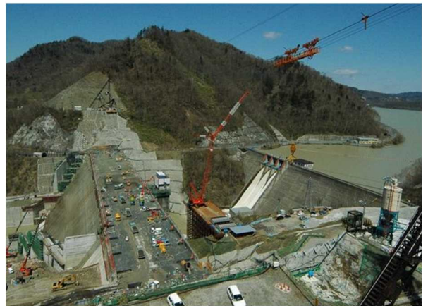
図 3-1-3-51 工事実施状況（平成 23 年 6 月撮影）
