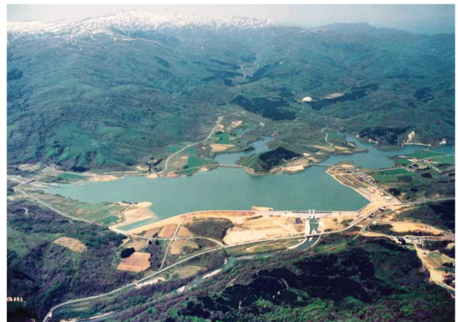
図 3-1-3-36 美利河ダム（平成 3 年 5 月試験湛水中）
