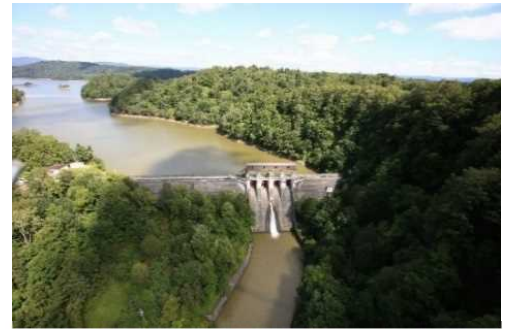
図 3-1-3-58 雨竜第二ダム（平成 29 年 9 月撮影）
