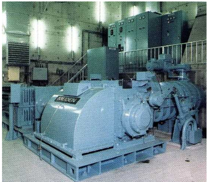
図 3-1-3-6 管理用水力発電設備
