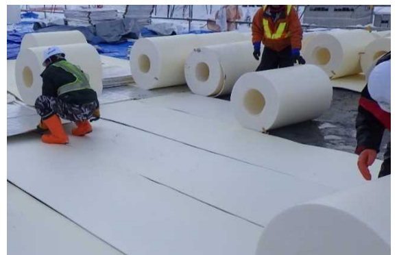
写真-5 養生の施工状況
