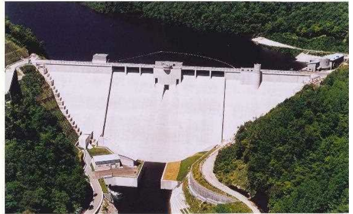
図 3-1-3-11 札内川ダム（平成 10 年 7 月竣工）
