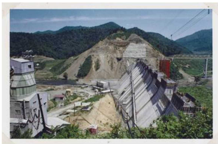
図 3-1-3-4 ダム本体工事（昭和 45 年 6 月）
