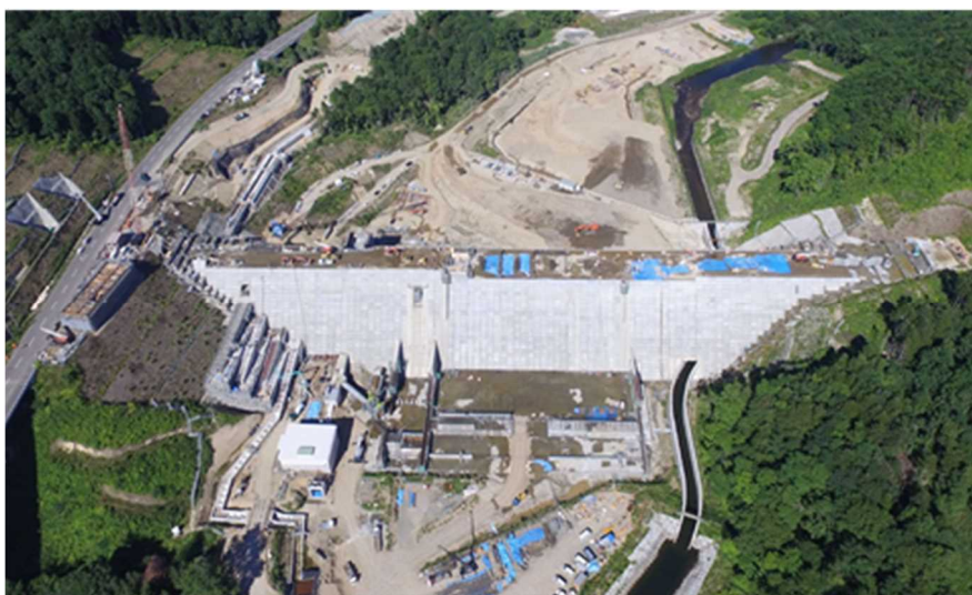
図 3-1-3-49 堤体打設状況（平成 29 年 8 月）
