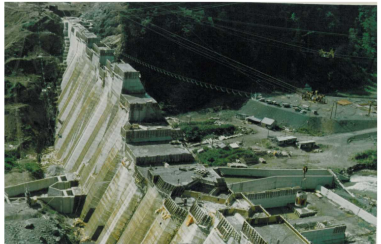
図 3-1-3-23 最盛期を迎えたダムコンクリート打設 (昭和 40 年。中空重力式ダムの I 型断面と中空部がよく現れている)
