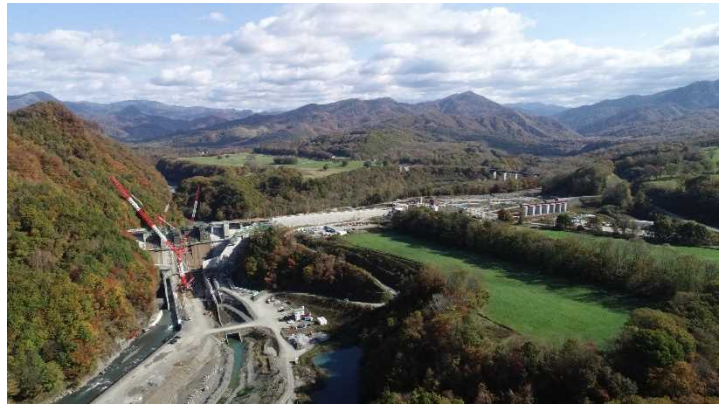
図 3-1-3-18 平取ダム施工状況
