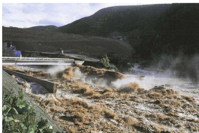
図 3-1-3-28 昭和 56 年 8 月 5 日 洪水吐下流
