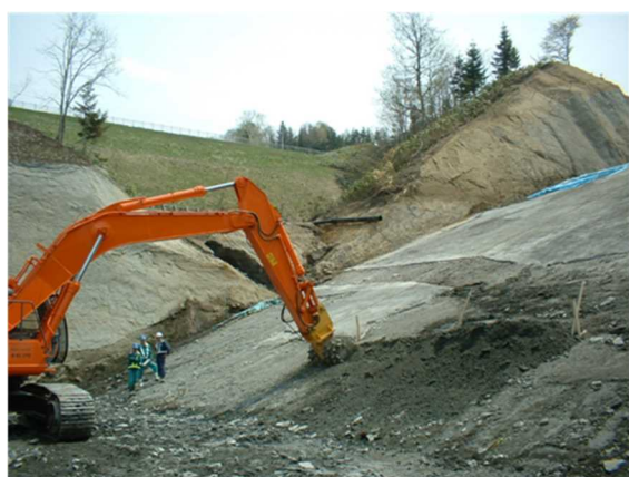
図 3-1-3-32 仕上掘削状況
