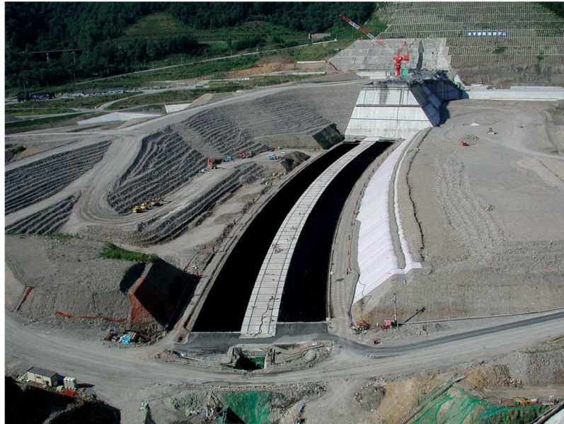
図 3-1-3-44 フィル部 コア敷保護工
