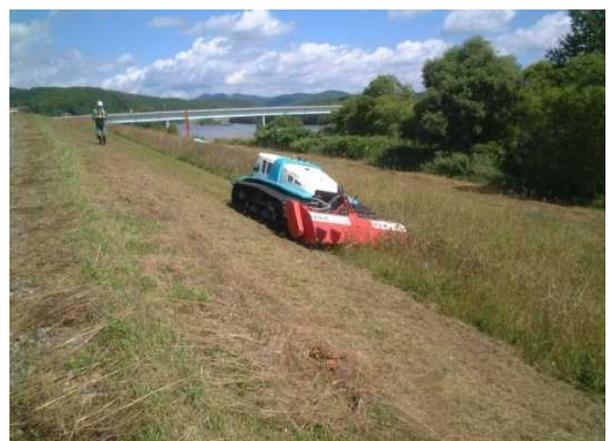
図 3-1-4-10 ラジコン式機械による堤防除草
