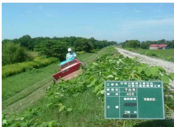
図 3-1-4-9 ハンドガイド式機械による堤防除草
