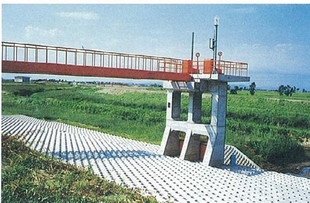
図 3-1-4-7 樋門動力巻き上げ機
