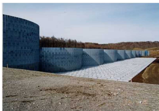
図 3-1-5-13 鋼製セル構造を採用した砂防施設
