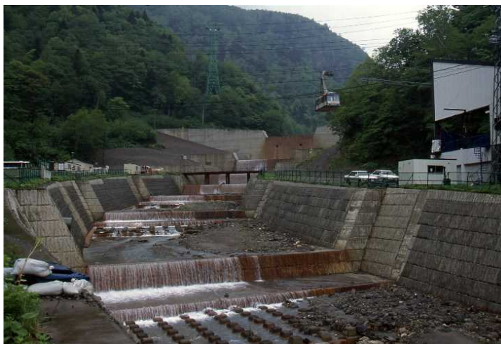
図 3-1-5-2 化粧ブロックを使っている黒岳沢川流路工
