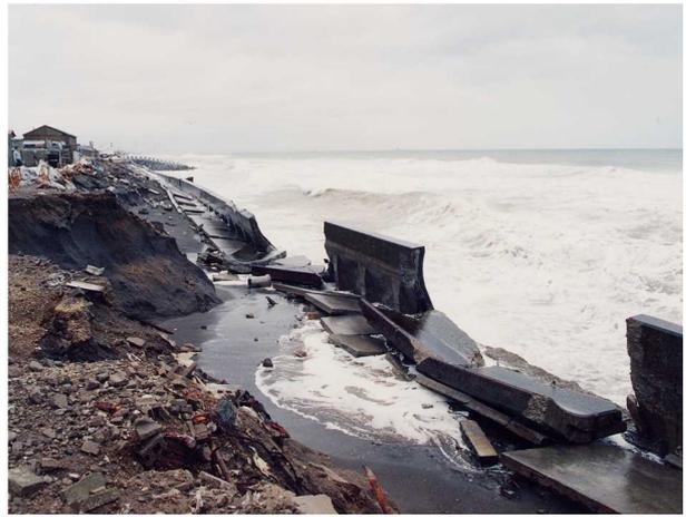
図 3-1-6-2 胆振海岸における直立護岸の倒壊災害状況
