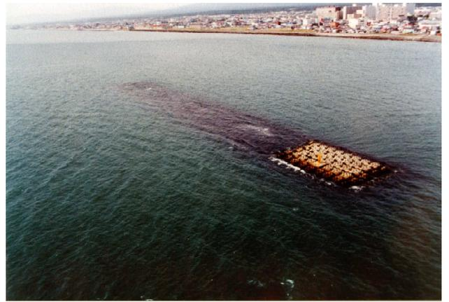
図 3-1-6-8 通常は水面下に没している人工リーフ
