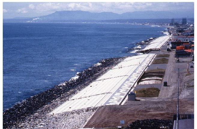
図 3-1-6-9 海辺へのアクセス性に優れた緩傾斜護岸
