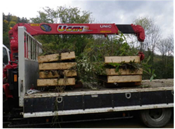
写真 16 積込運搬作業状況
