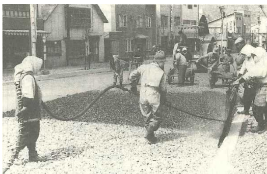
写真 1 アスファルトマカダムの施工状況
