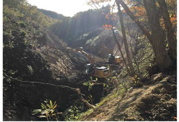
写真7 ICT 建設機械による施工状況
