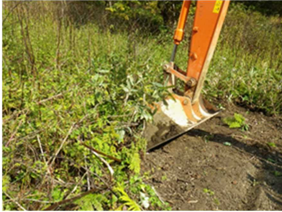
写真 15 根切り作業状況
