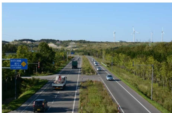
写真3 国道40号 更喜苫内防雪（稚内市・豊富町）
