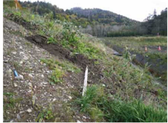
写真 18 表土ブロック定置直後
