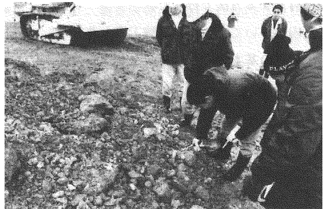
写真9 除雪中の敷均転圧
