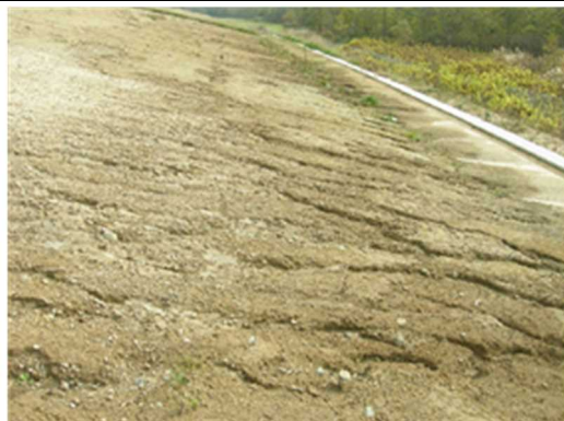
写真 10 すき取り物を施工していない法面
