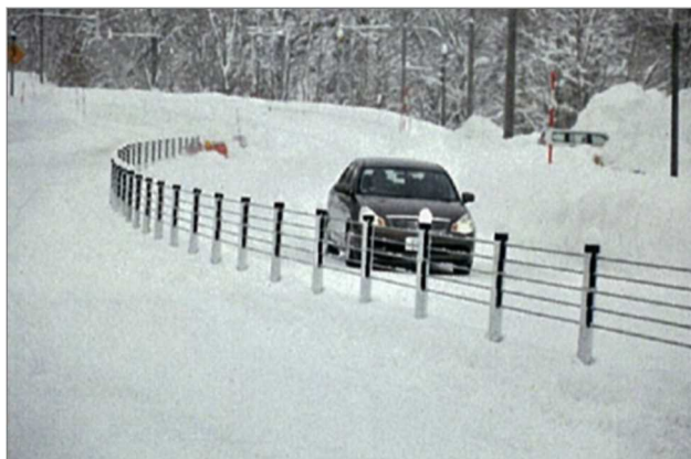
写真6 国道275号（音威子府村天北峠）
