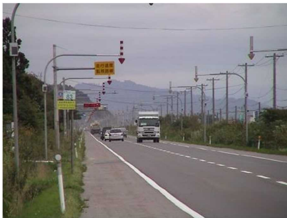
写真4 国道5号（八雲町）【施工前】
