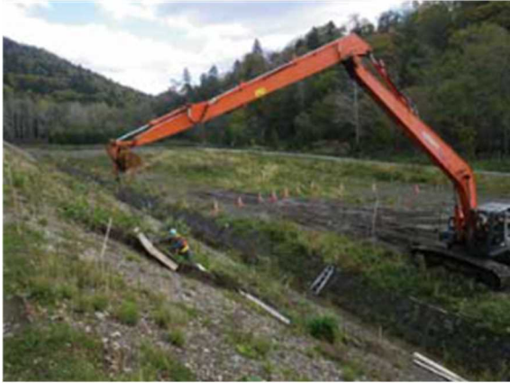
写真 17 表土ブロック設置作業状況
