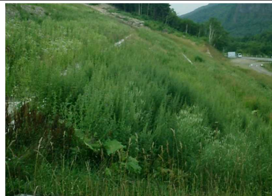
写真 11 すき取り物を施工した法面
