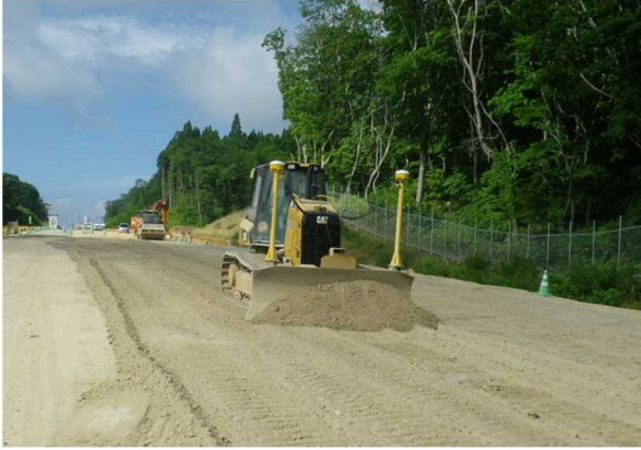
写真7 ICT 建設機械による施工状況
