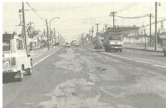
写真 3 市街部の摩耗状況
