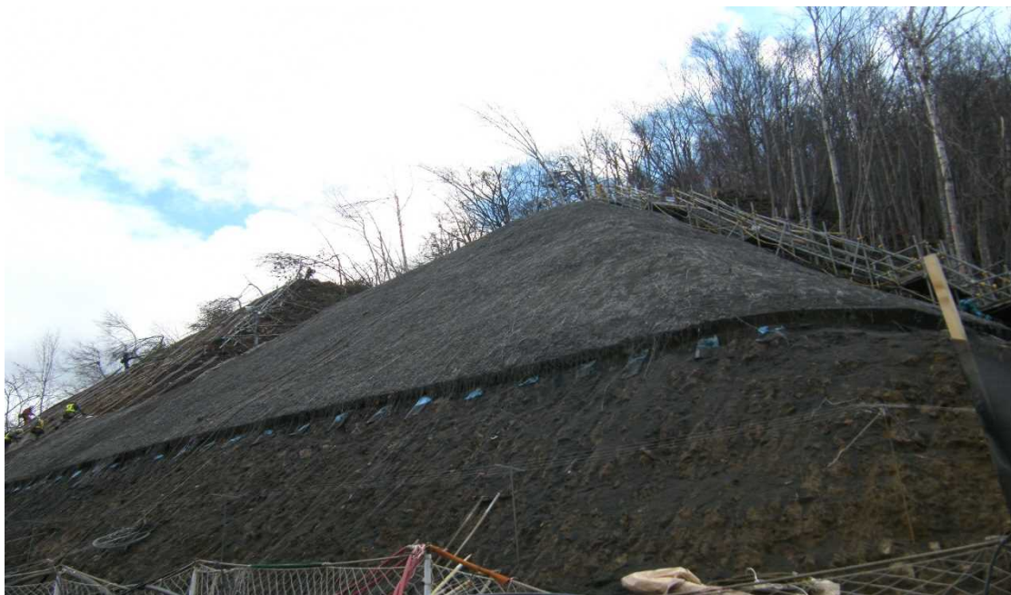
写真 14 連続繊維補強土工による法面保護工法
