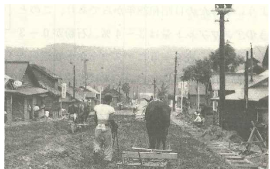
写真 2 セメント安定処理の施工
