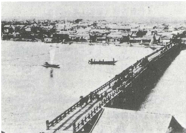
初代の橋（明治 33 年～明治 42 年）
