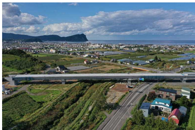
写真 12 登川大橋（国道 5 号 余市町）
