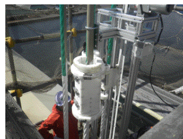
写真21 専用器具によるハンガーロープ塗装塗り替えの試験施工
