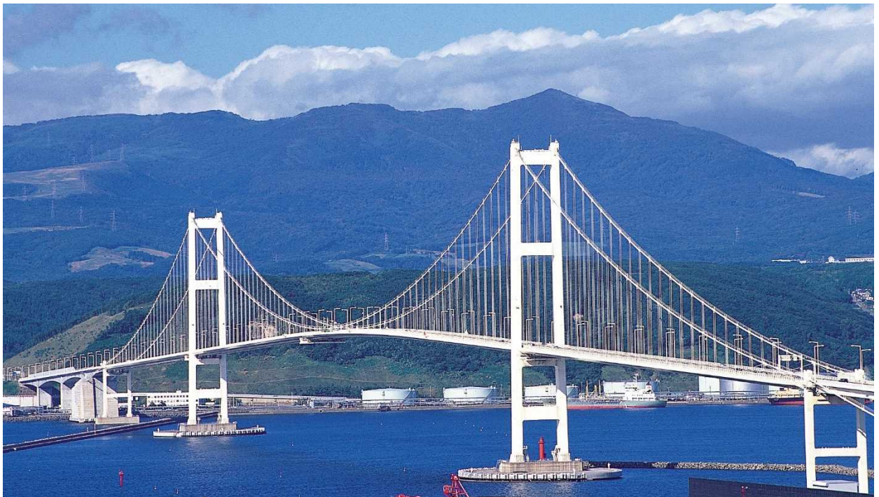
写真 10 白鳥大橋（平成 10 年～現在）（国道 37 号 室蘭市）
