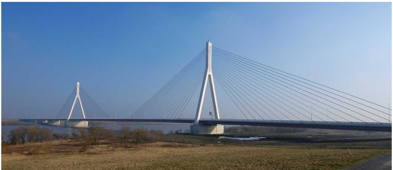
写真 11 美原大橋（国道 337 号 江別市） （平成 17 年～現在）
