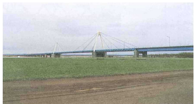
写真 5 石狩河口橋 （国道 231 号 現石狩市）
