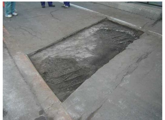
写真 13 床版上面の砂利化
