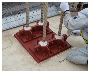
写真20 ハンガーロープ定着部の補修
