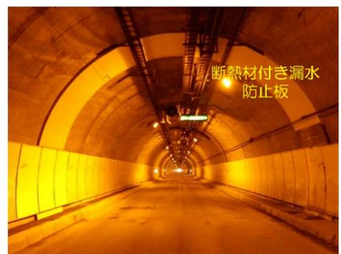
写真6 漏水・氷柱対策工
