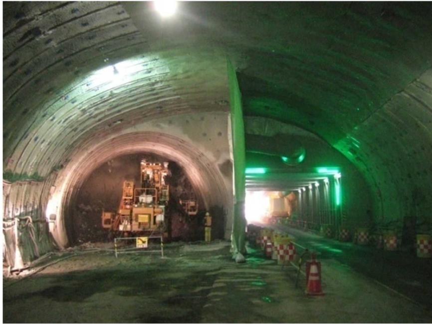
写真2 国道336号 えりも黄金トンネル施工時の分岐掘削状況
