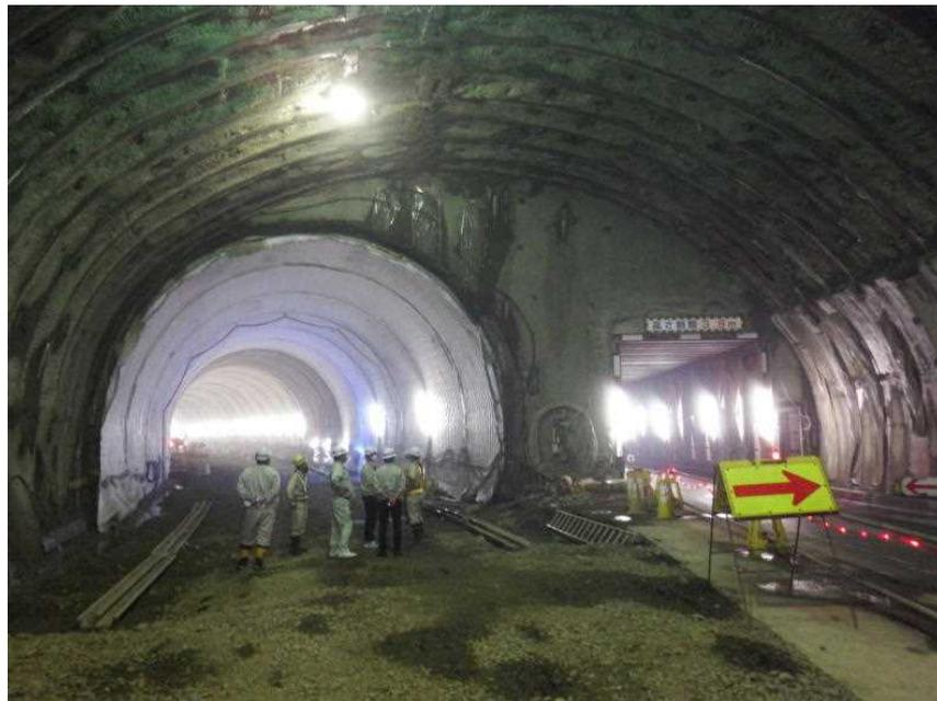
写真3 国道231号 浜益トンネル施工時の分岐掘削状況
