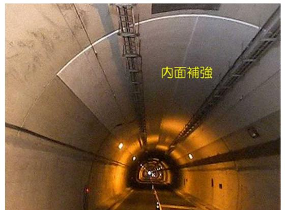
写真4 内面補強工
