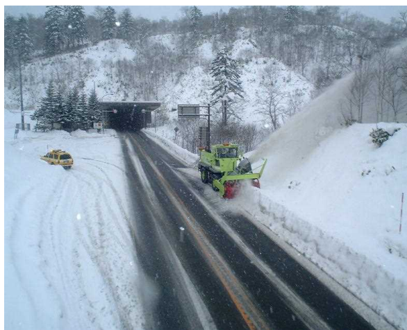
写真4 山間部における拡幅除雪
