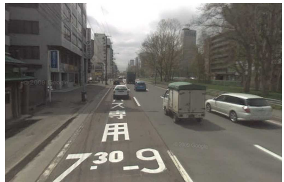
写真 3 国道 5 号札幌市中央区 北 12 条～北 1 条バスレーンのカラー舗装
