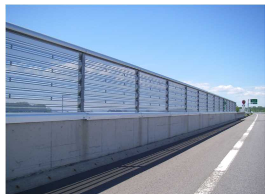
写真 18 飛雪防止網（深川・留萌自動車道）
