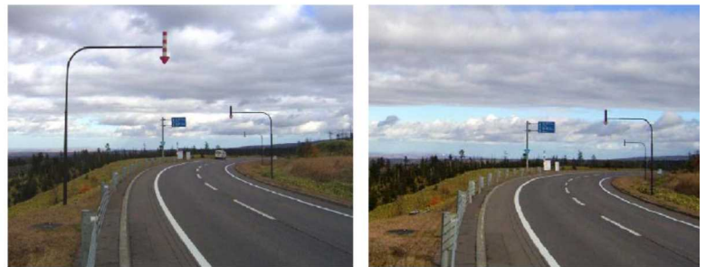
写真 12 収納式矢羽根 収納前（左）、収納後（右）
