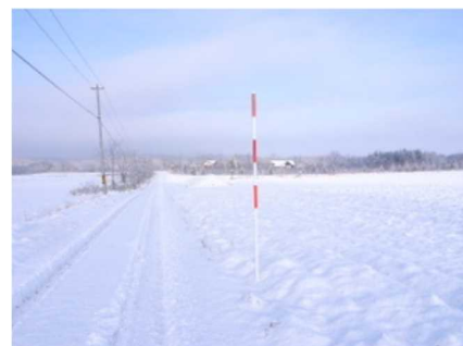
写真7 スノーポール
