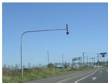
写真8 固定式視線誘導柱
