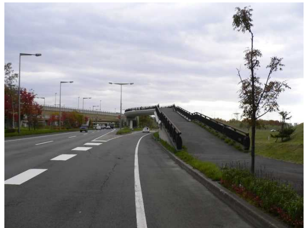
写真 18 スロープ式の横断歩道橋
