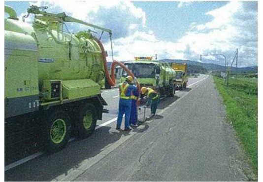
写真9 側溝清掃車による雨水枥清掃状況
