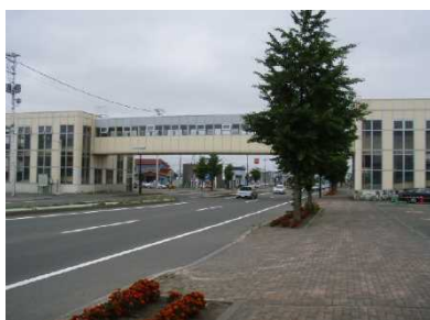
国道 12 号幌向横断歩道橋
