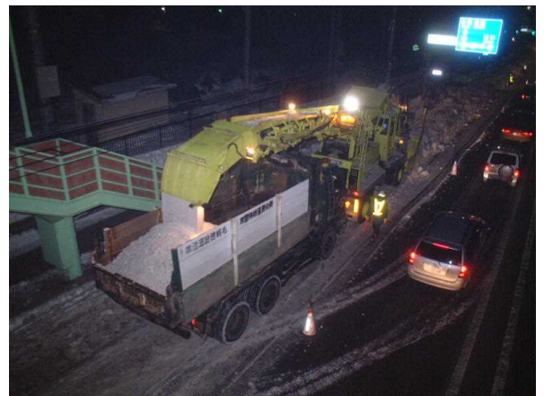
写真 6 一車線積込型による運搬排雪
