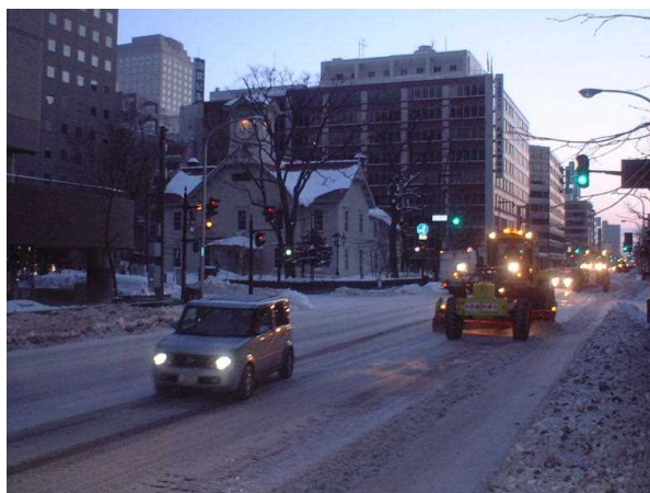
写真3 市街部における路面整正作業
