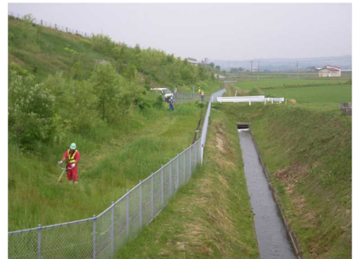
写真 3 立入防止柵付近での除草 (深川留萌自動車道)
