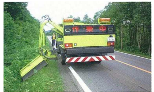
写真1 法面における機械除草
