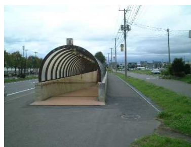
国道 274 号西の里地下横断歩道
