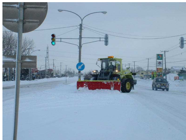
写真 11 除雪ドーザによる交差点の除雪
