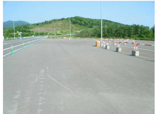
写真 15 高規格幹線道路の除雪車旋回場 （国道 5 号 黒松内 IC 付近）
