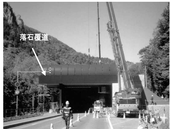
写真 1 屏風岩覆道における実験状況
