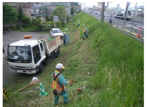
写真2 人力除草（肩掛け式）
