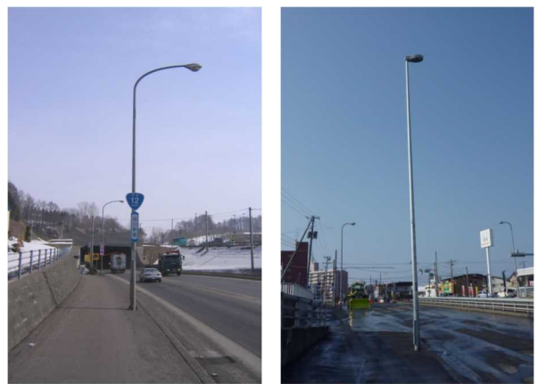
写真 14 道路照明施設の型式 （左：従来型 右：直線ポール型）
