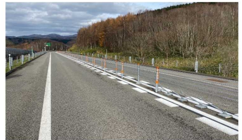
写真 3 ワイヤロープ式防護柵 ( E5A 黒松内新道)
