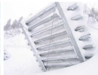
写真6 ネット設置によるすり抜け対策例
