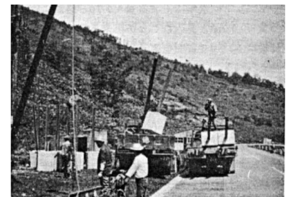
写真4 工場製作品搬入状況 (38号)
