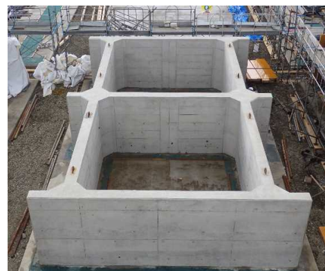
写真-2 セルラーブロックの製作状況
