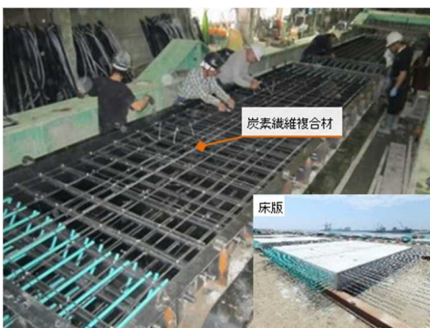
写真－5 炭素繊維複合材（CFRP）を用いた PC 床版
