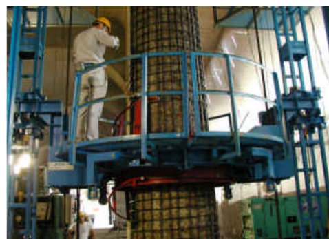
写真－2 PC鋼線自動巻き付け機
