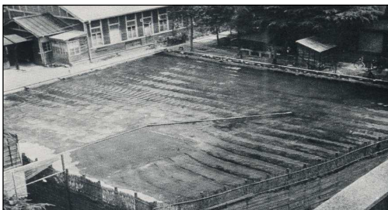
図-8 建設省土木研究所での模型実験
