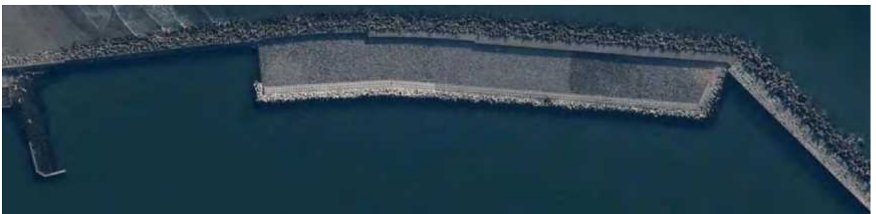
写真-3 長周期波対策工の航空写真
