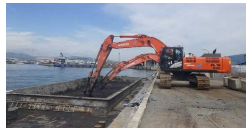
写真－5 バックホウによる浚渫土とカルシア改質材の混合状況
