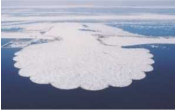
写真-4 流氷の流入を防止するアイスブーム（サロマ湖漁港）
