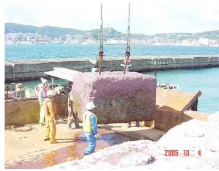
写真-3 捨塊撤去状況（門）
