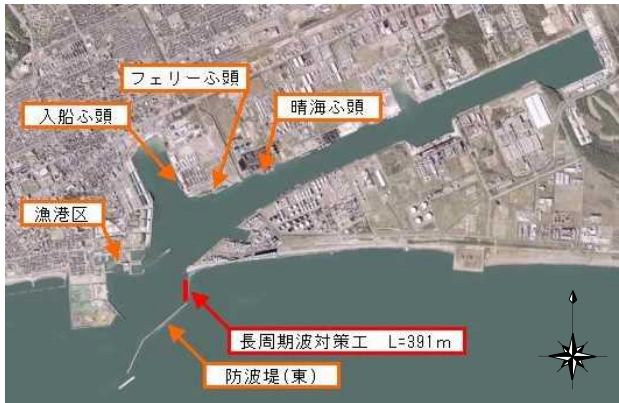
写真－1 長周期波対策工施工箇所と各施設の位置
