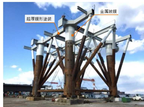
写真－6 金属腐食を防ぐジャケットの長寿命化短縮
