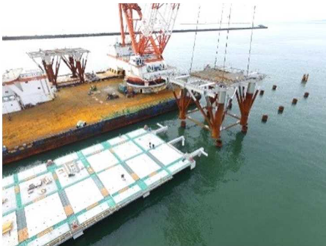
写真－3 ジャケットの据付工法
