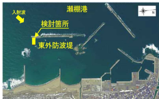
写真-3 瀬棚東外防波堤検討箇所
