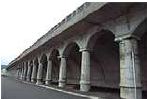
写真－1 稚内港北防波堤ドーム
