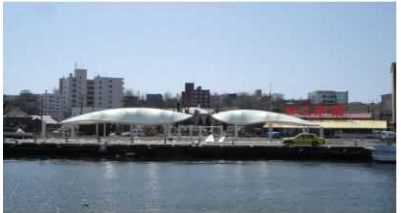
写真-5 釧路港津波漂流物対策施設
