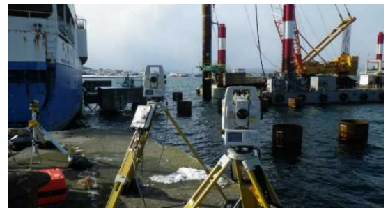
写真－4 自動追尾式トータルステーションを使用した鋼管杭打設状況
