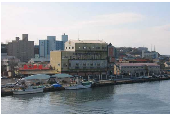
写真－１ 商業施設前に整備された対策施設
