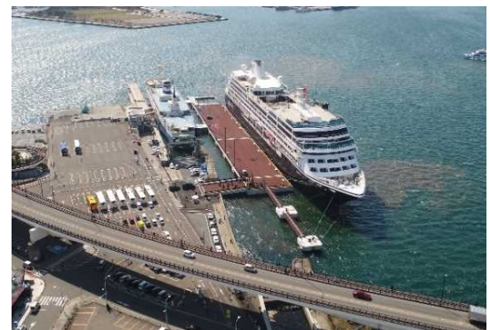
写真－1 若松地区-10m岸壁暫定供用時の利用状況
