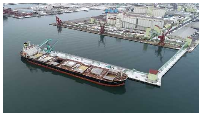
写真－2 水深14m岸壁の利用状況
