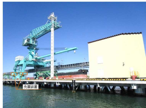
写真－4 免震装置を備えるアンローダー
