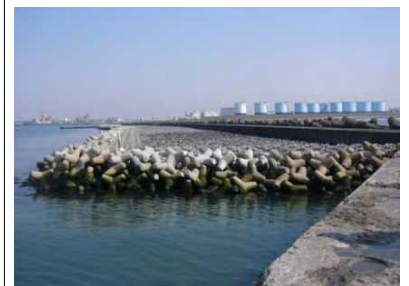
写真-2 長周期波対策工の完成写真
