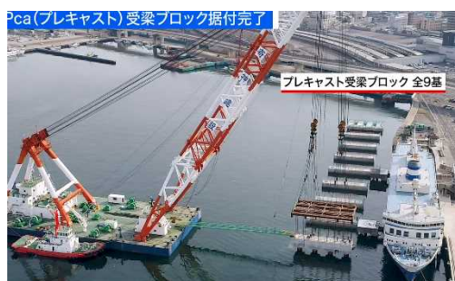
写真－2 大型起重機船によるプレキャスト受梁の据付状況
