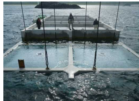
写真-4 セルラーブロック据付状況
