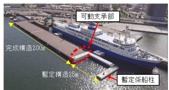
写真－3 暫定供用部完成状況
