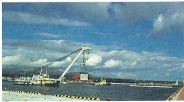
写真-3 たいせつ号 (500t 吊) によるケーソン据付
