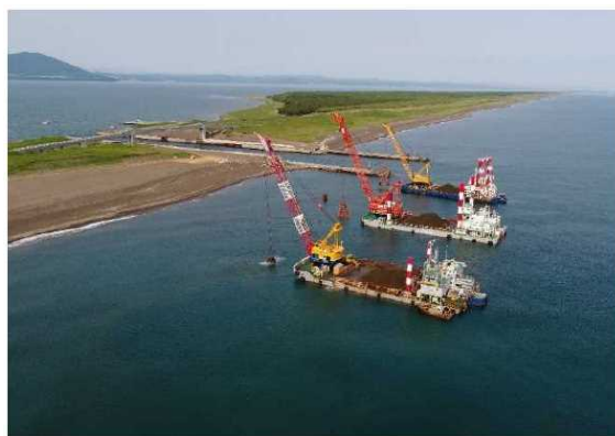
図-5 サンドポケット造成 施工状況
