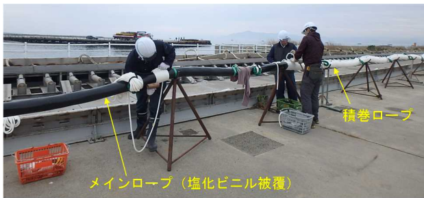
図-8 メインロープの積巻作業状況
