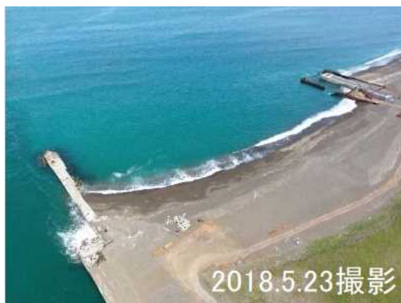
図-6 サンドポケット完成状況
