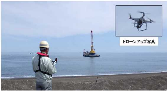
図-7 ドローンによる土量計測状況
