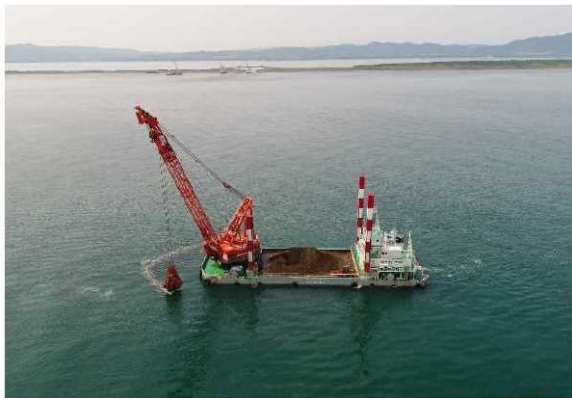
図-9 浚渫土の海洋投入処分状況
