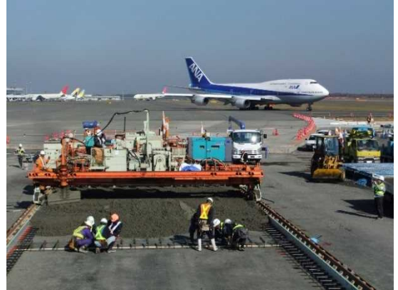
写真-5 エプロン舗装工事
