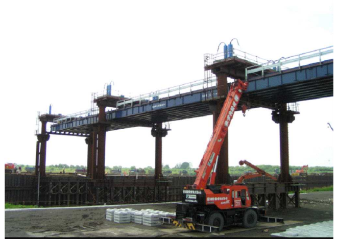
写真-14 リフティング工法用ジャッキを使用した栈橋
