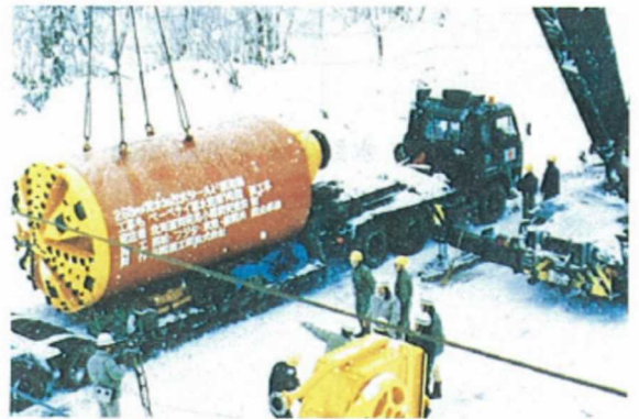
写真-22 双葉地区導水路工事のシールド掘削機
