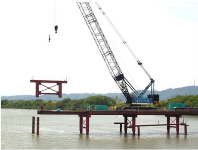
写真-13 作業構台施工状況
