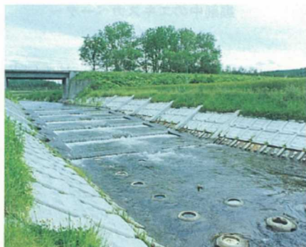
写真-29 魚の遡上及び生息可能な落差工
