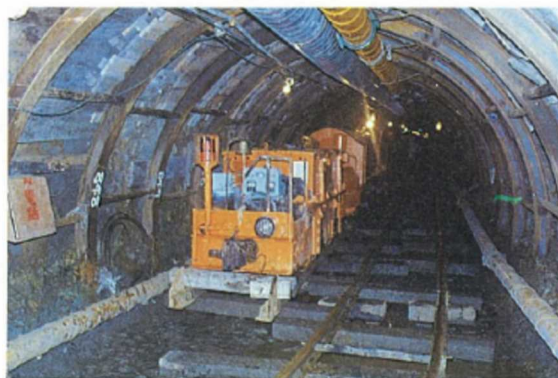
写真-23 トンネル内とシャトルカー
