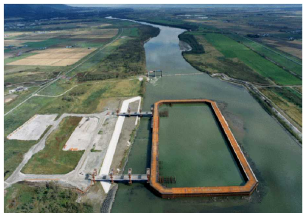
写真-12 石狩川頭首工仮締切状況
