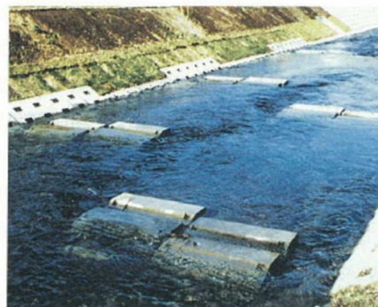
写真-30 棲息ブロックの設置状況
