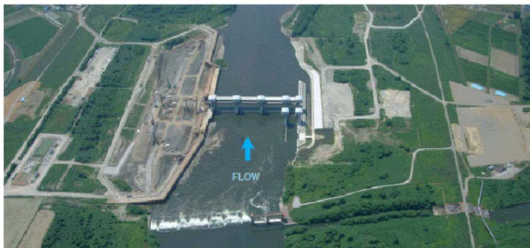
写真-15 施工中の新石狩川頭首工（写真中央）と旧石狩川頭首工
