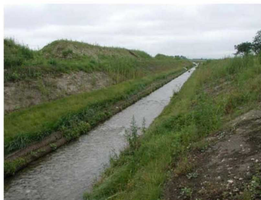
写真－31 植生ロール使用護岸
