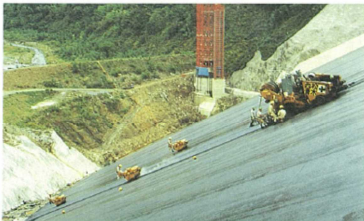
写真－7 フェーシングの舗設作業
