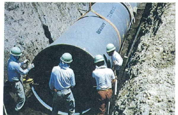
写真-18 強化プラスチック複合管の敷設状況
