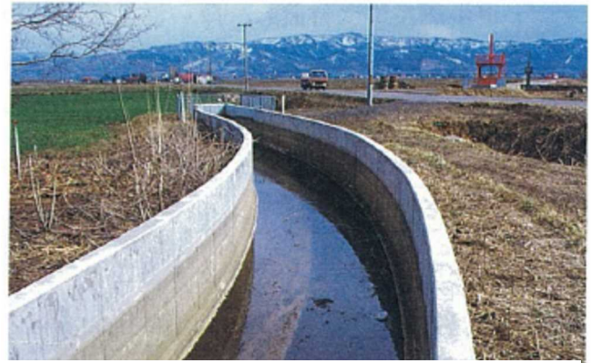
写真-16 場所打コンクリートライニング水路
