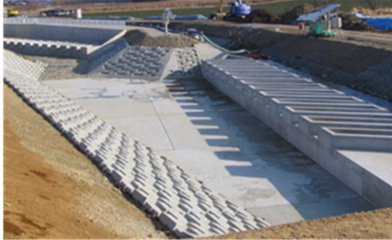
写真-32 完成したラビリンス堰（第1分流）
