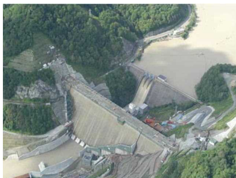
写真－1 大夕張ダムと建設中の夕張スーパーダム
