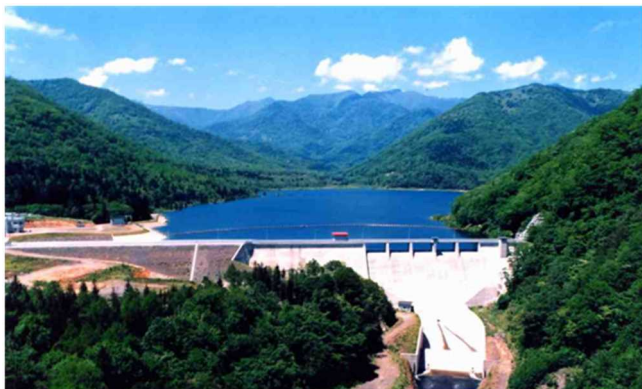
写真－8 下流から見た美生ダム
