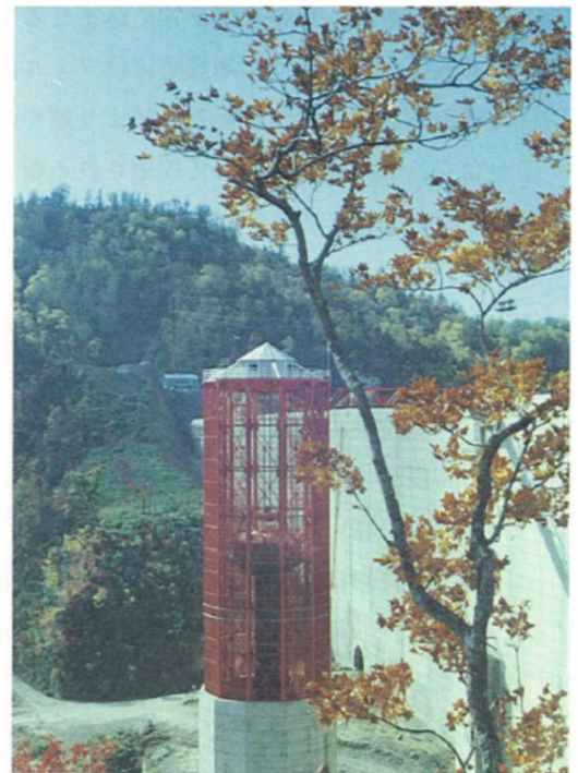
写真-9 フローティング取水塔
