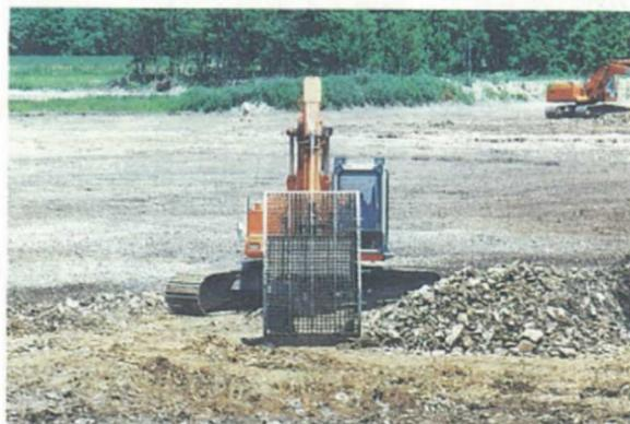
写真-35 石礫除去の機械施工（ストーンローダ）
