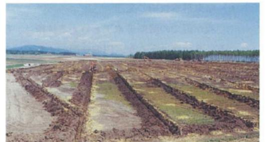
写真-43 暗渠工の施工
