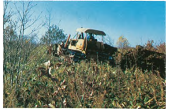
写真-60 伐根作業
