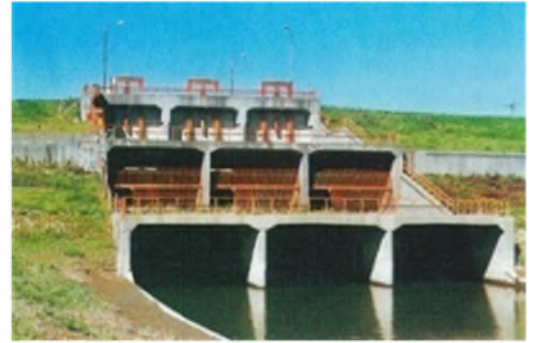
写真-52 石狩川頭首工中空式樋門
