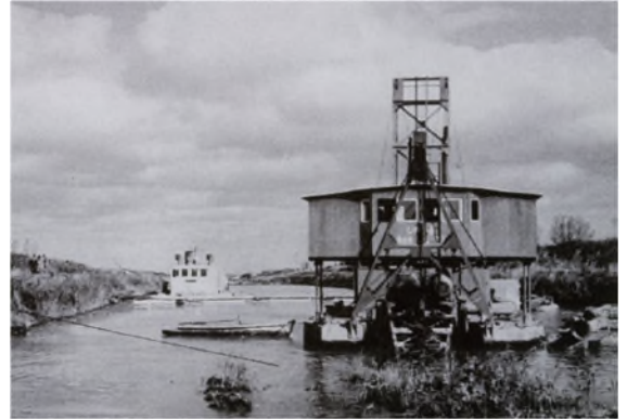
写真—50 ポンプ船による運河掘削
