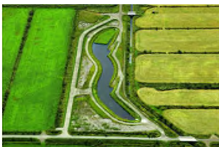
写真-63 遊水池（排水路下流部）
