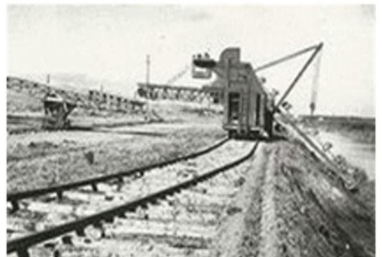
写真-49 ラダーエクスキャベーターによる水路掘削
