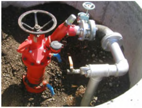
写真-70 自動定圧定流量分水栓
