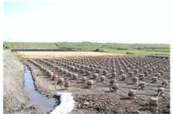
写真-53 パイルネット工法の施工例
