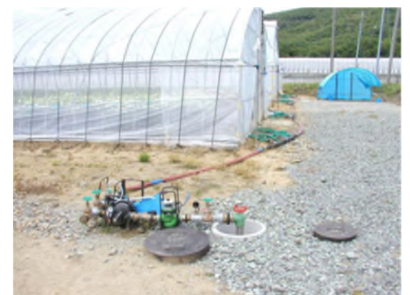
写真-79 定流量自動停止弁による水作業の自動化
