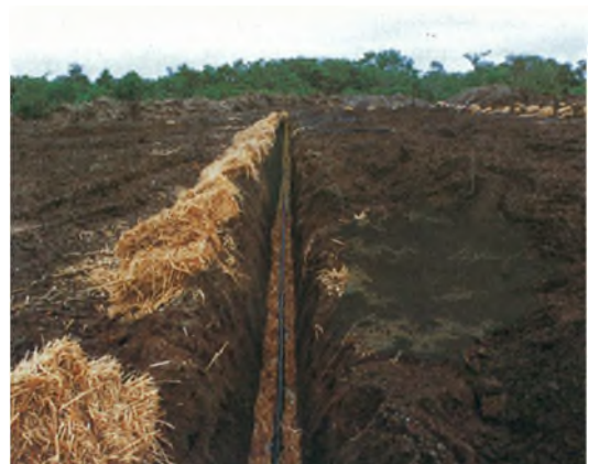
写真-59 暗渠排水
