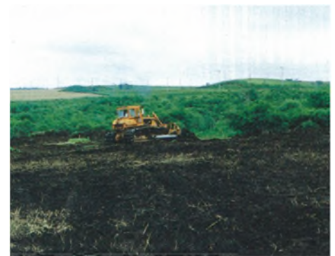
写真-56 ブルドーザーによる開墾
