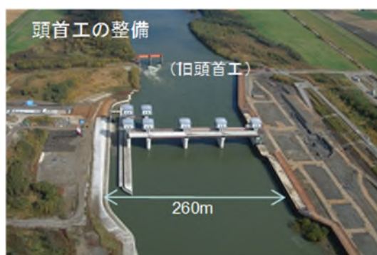
写真-54 石狩川頭首工
