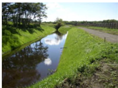
写真-62 排水調整池 （排水路上流部）
