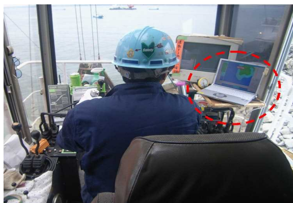
図-25 システムを用いた捨石投入状況
