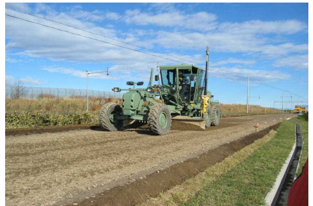
図-32 MG 技術による敷均し作業
