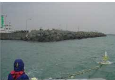
図-22 消波ブロック計測状況
