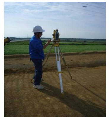
図-33 TS による出来形管理
