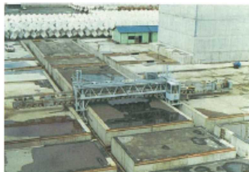
図-28 横行台車とシフトクレーン
