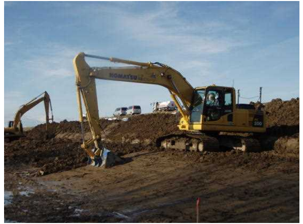
図-31 MG 技術による法面整形作業
