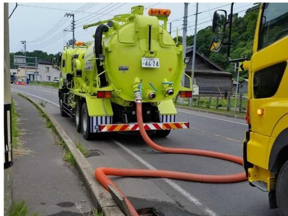
図-53 側溝清掃作業
