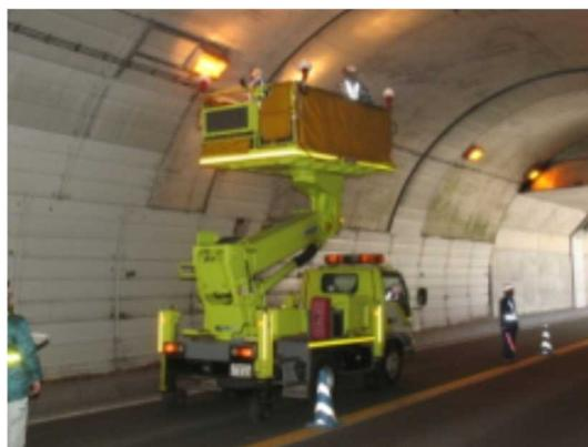
図-60 トンネル点検作業
