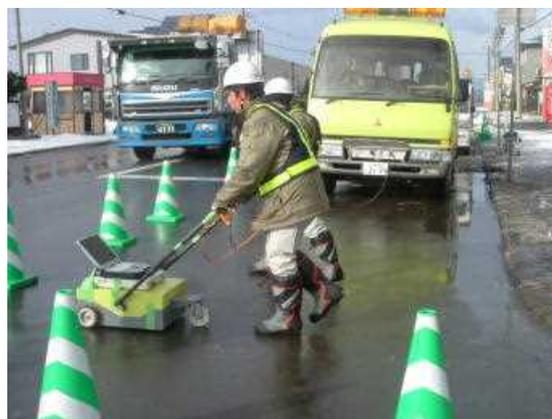
図-62 二次探査状況(ハンディ型レーダ調査)
