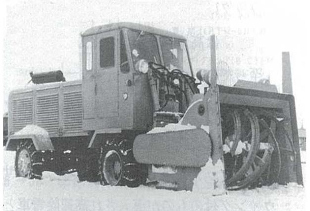
図-75 ロータリ除雪車(170ps 級)
