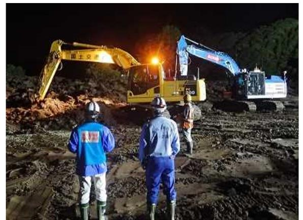
図-111 分解組立型バックホウ
