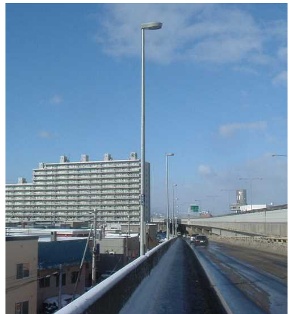
一般国道 5 号の道路照明
