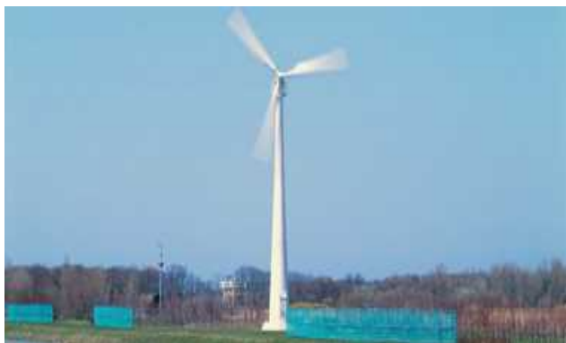
石狩放水路管理センターの風力発電設備
