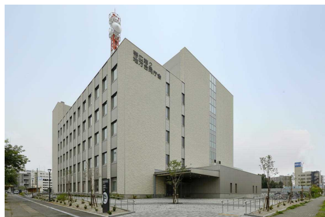
図 6-18 帯広第 2 地方合同庁舎(令和元年完成) (金属成型板+ハンギングタイル工法)
