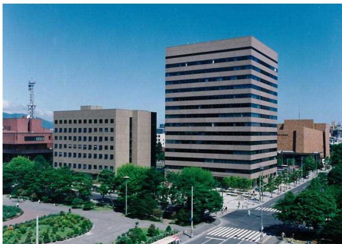
図 6-59 札幌第 3 合同庁舎(平成 6 年完成)
