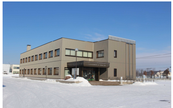
図 6-13 旭川運輸支局(令和元年改修) (ガルバリウム鋼板)
