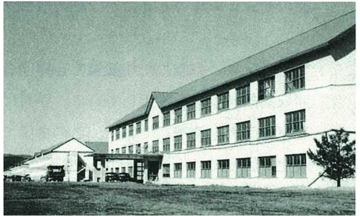
図6-26 保安隊第2管区総監部(昭和28年完成) (セメントウォーターペイント)
