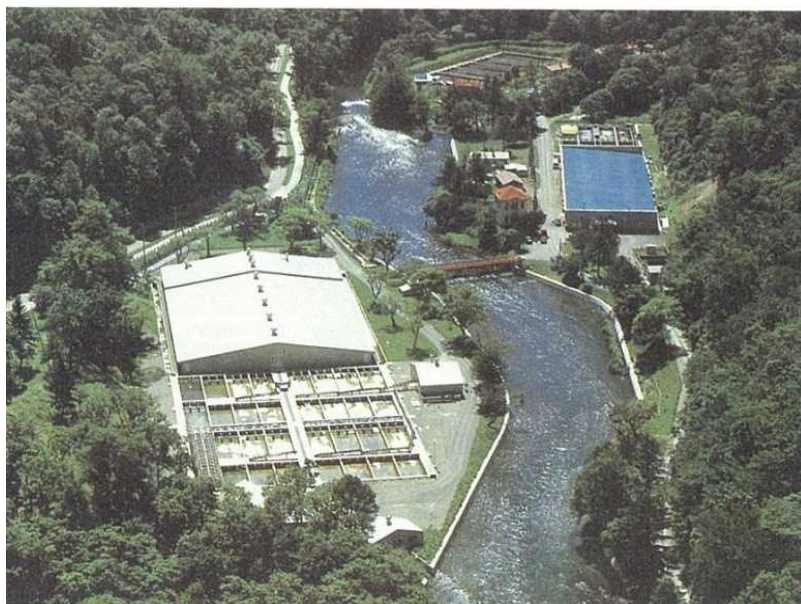
図 6 -69 北海道さけ・ますふ化場千歳支場(平成元年当時)
