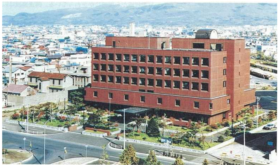
図 6-64 函館裁判合同庁舎(昭和 60 年完成)
