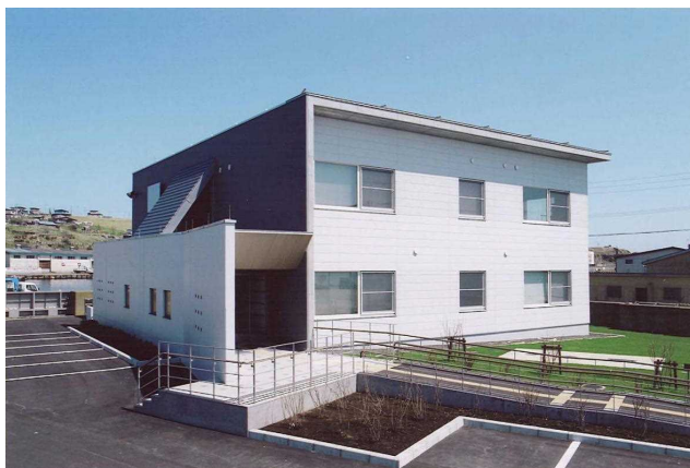
図 6-20 花咲港湾合同（平成 17 年完成）
