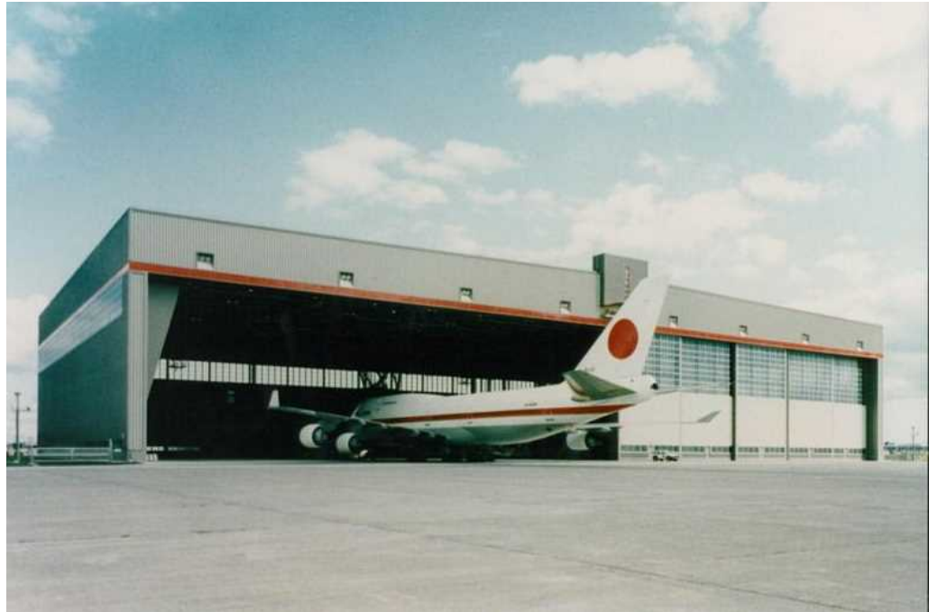
図 6-77 政府専用機格納庫(平成 4 年完成)
