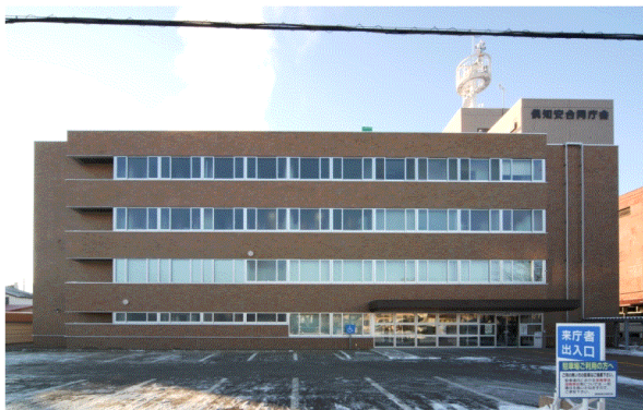
図 6-12 倶知安地方合同庁舎(平成 21 年改修) (ハングングタイル工法)
