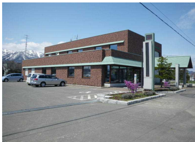
図 6-42 旭川公共職業安定所 富良野出張所(平成 12 年完成)
