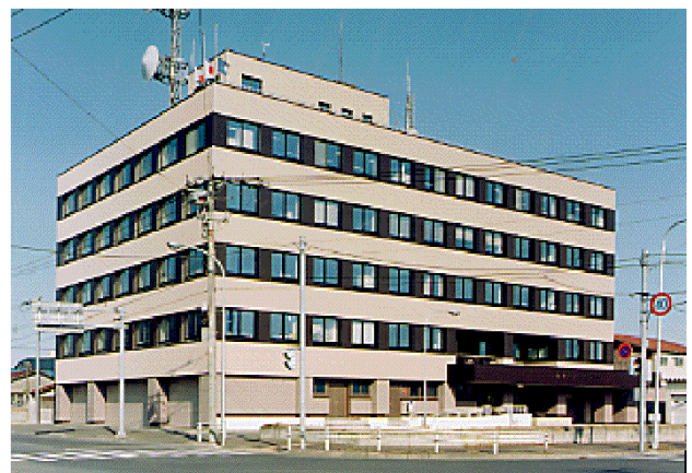
図 6-10 釧路港湾合同庁舎(平成 14 年改修) (金属成型板)
