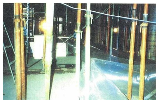
図 6-32 仮設ダクト配管
