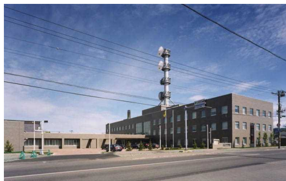
図 6-14 留萌開発建設部(平成 13 年完成) (レンガタイル積上げ工法)
