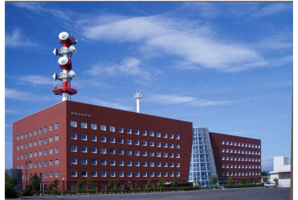
図 6-15 旭川地方合同庁舎(平成 20 年完成) (ハングングタイル工法)
