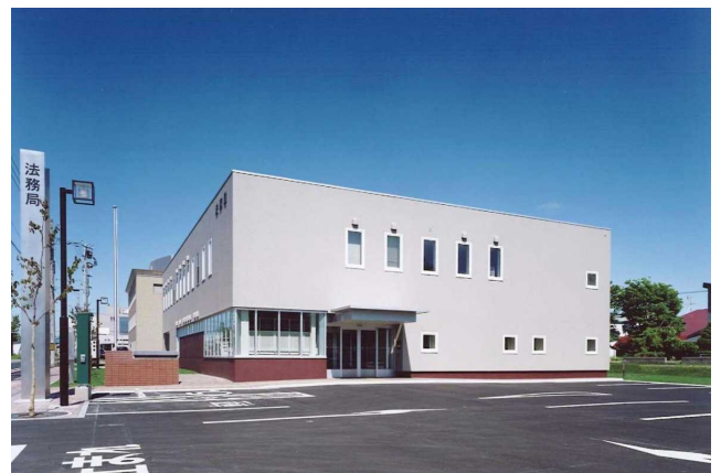
図 6-21 札幌法務局岩見沢支局（平成 18 年完成）
