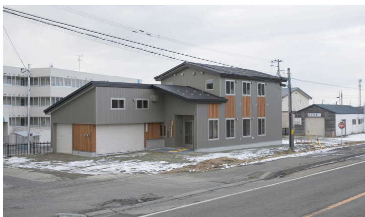
図 6-43 えりも自然保護官事務所（平成 30 年完成）
