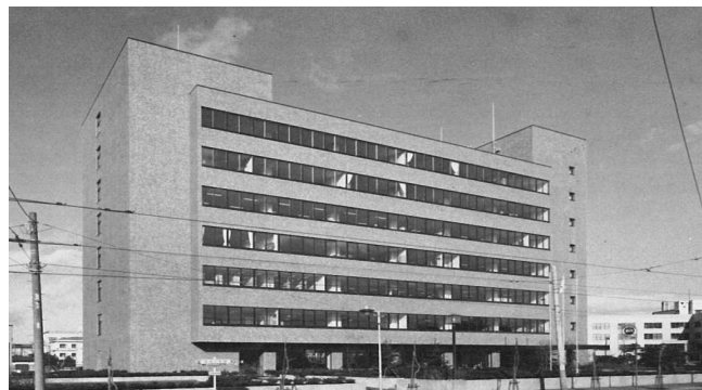
図 6-30 函館地方合同庁舎(昭和 54 年完成) (タイル型枠先付け)
