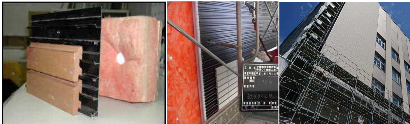
図 6-16 ハンギングタイル工法
