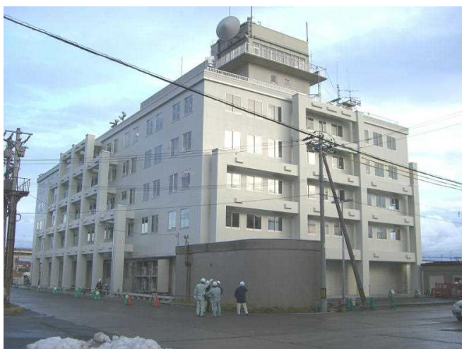
図 6-36 函館港湾合同庁舎(平成 21 年改修)
