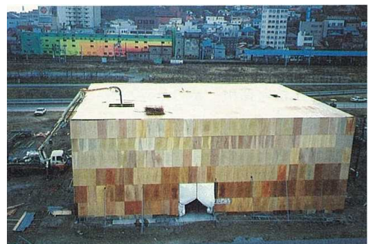
図 6-31 実施例（2 F 躯体養生）
