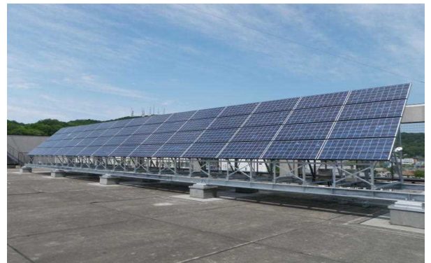
図 6-24 室蘭地方合同庁舎 (平成 21 年既存庁舎に設置：10kW)
