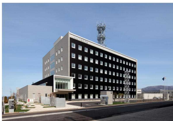
図 6-17 小樽地方合同庁舎(平成 21 年完成) (金属成型板+ハンギングタイル工法)
