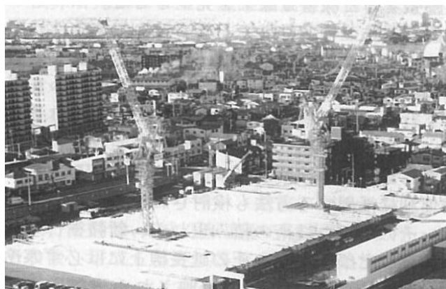
図6-33 冬期養生上屋全景
