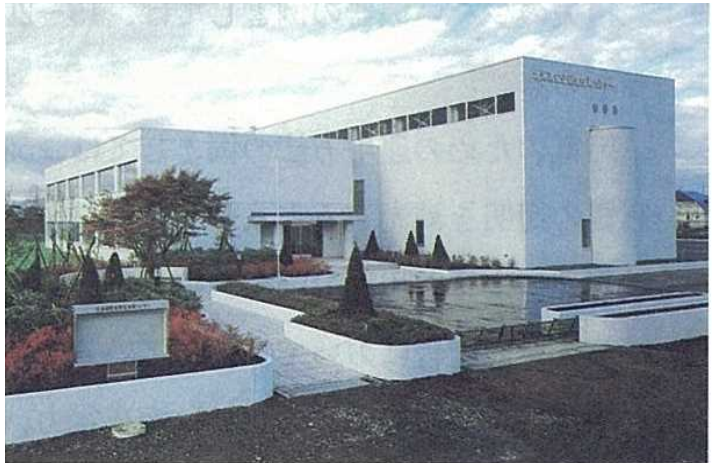
図6-27 北海道安全衛生技術センター(昭和62年完成) (複層仕上げ塗材)
