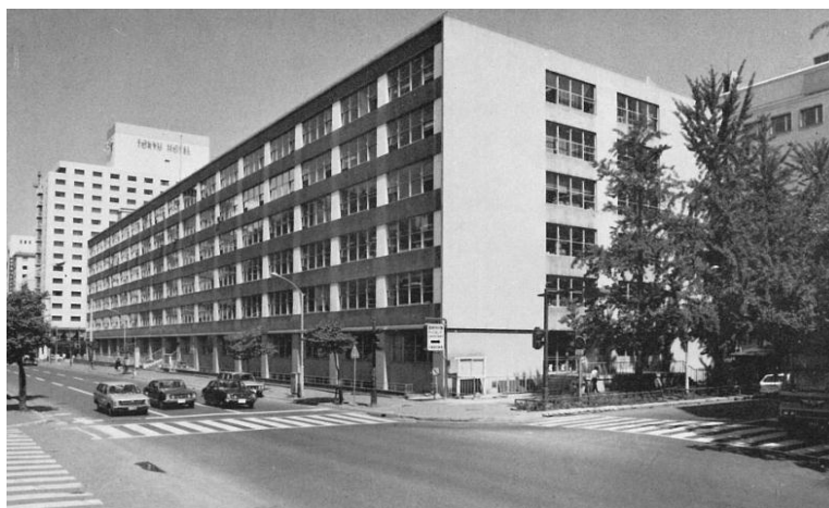
図 6-19 旧札幌第 1 地方合同庁舎(昭和 36 年完成) (上げ下げバランス式窓、複層硝子の採用)
