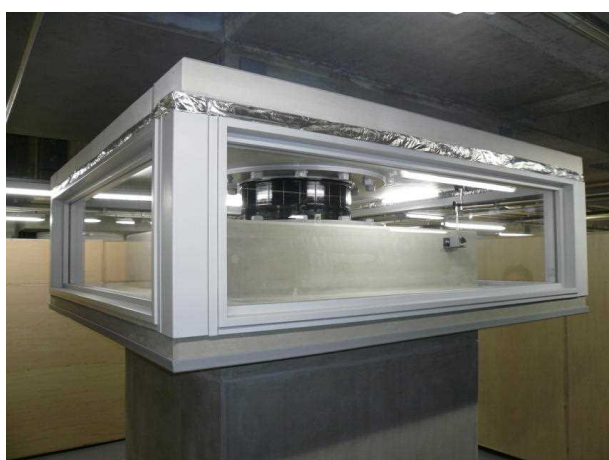
図 6-38 可視化されている免震装置 (札幌開発総合庁舎)
