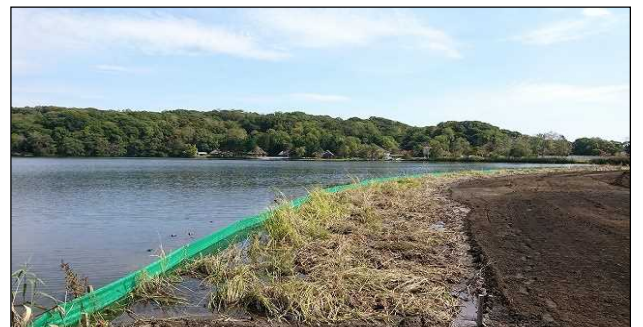
写真5 流失防止フェンスによる対策
