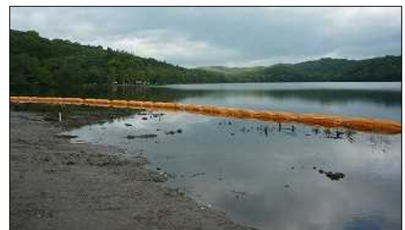
写真3 緩傾斜化(10割勾配)に造成された湖岸
