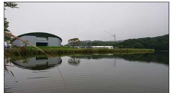
写真7 対岸から見た湖岸植生の状況
