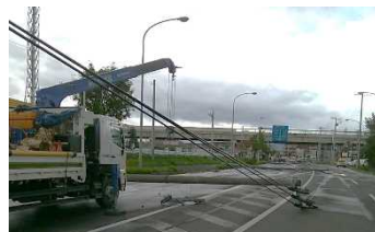
台風による電柱の倒壊 (国道275号 札幌市)
