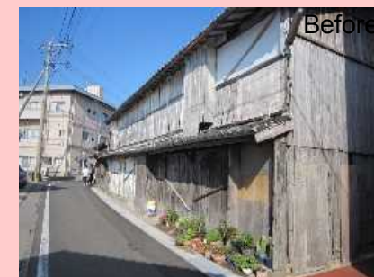
空き家の除却
