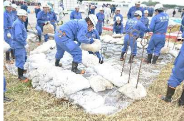
漏水対策工法 (月の輪工)
