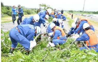
洗掘対策工法 (木流し工)
