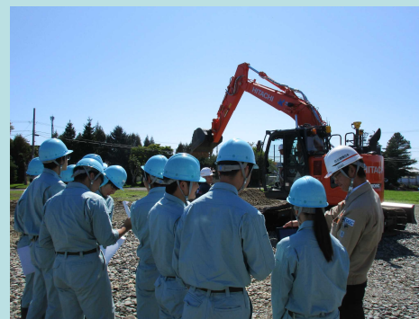
ICT建機のデモも見学しました
