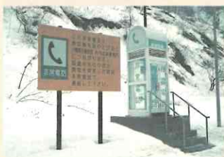
携帯電話が通じない場所にある非常電話ボックス。受話器をあげると自動的に道路事務所につながります
