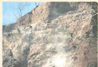
危険な岩を取り除いたり、落石被害を防止するための様々な工事
