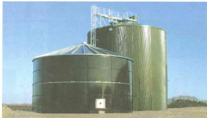
メタン発酵槽(右)とガスホルダー(左)
