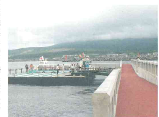
浮棧橋までは、階段のほかに、ゆるやかなスロープがつけられています。
